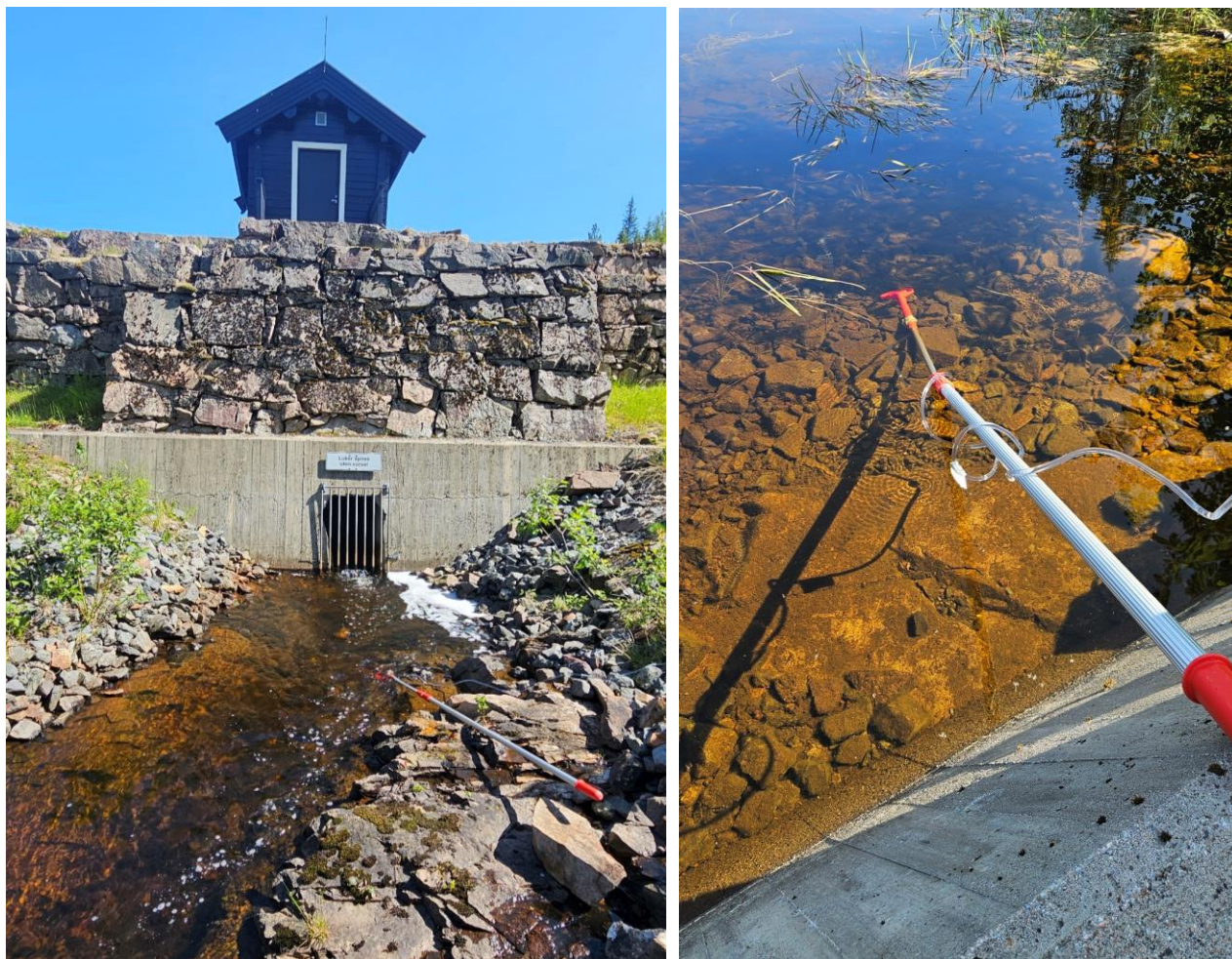
Figur 2-3. Bilder fra pumping av vann ved dam Trehørningen. Foto: Multiconsult ASA.
