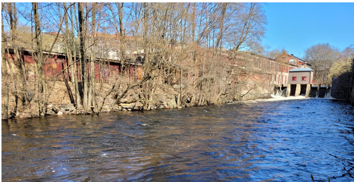
Figur 4.1: Akerselva langs planlagt skole.
