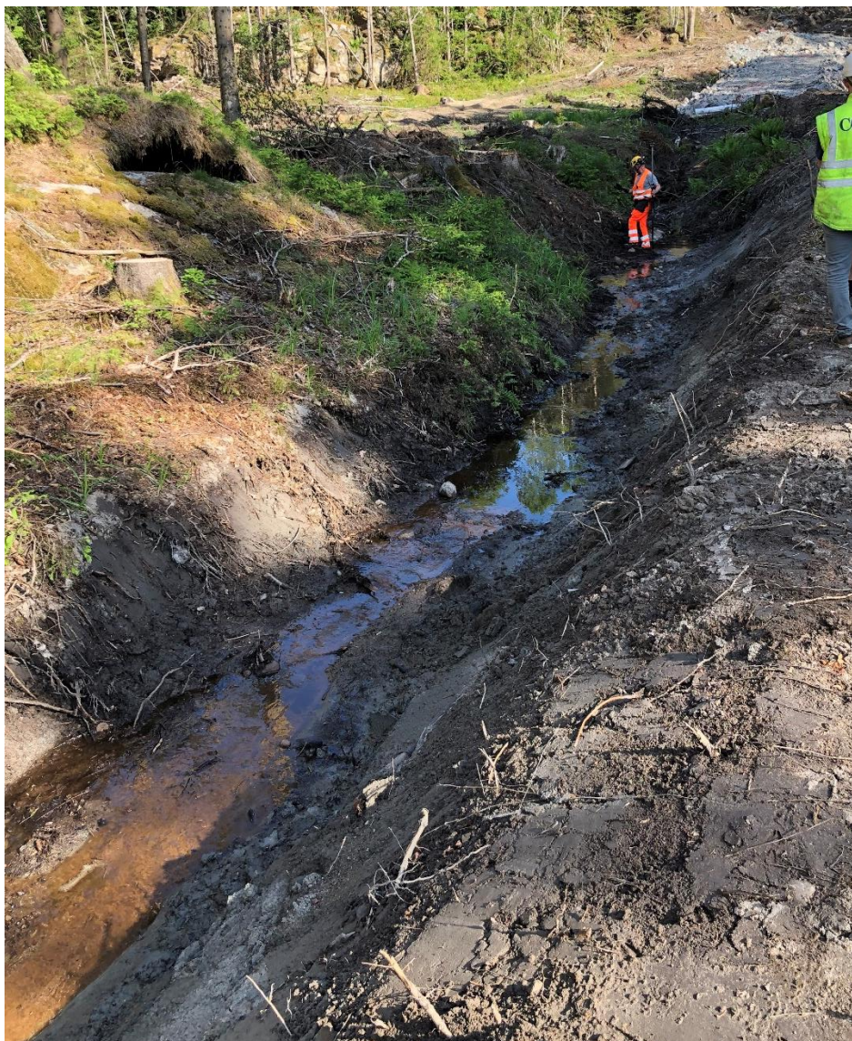
Figur V5-9: Foto tatt ved VL T3 P1340 og retning nord, befaring 17.06.21. Tynt løsmassedekke, enkelte bergblotninger i området nær bekken og kunstig utrettede bekkesider.
