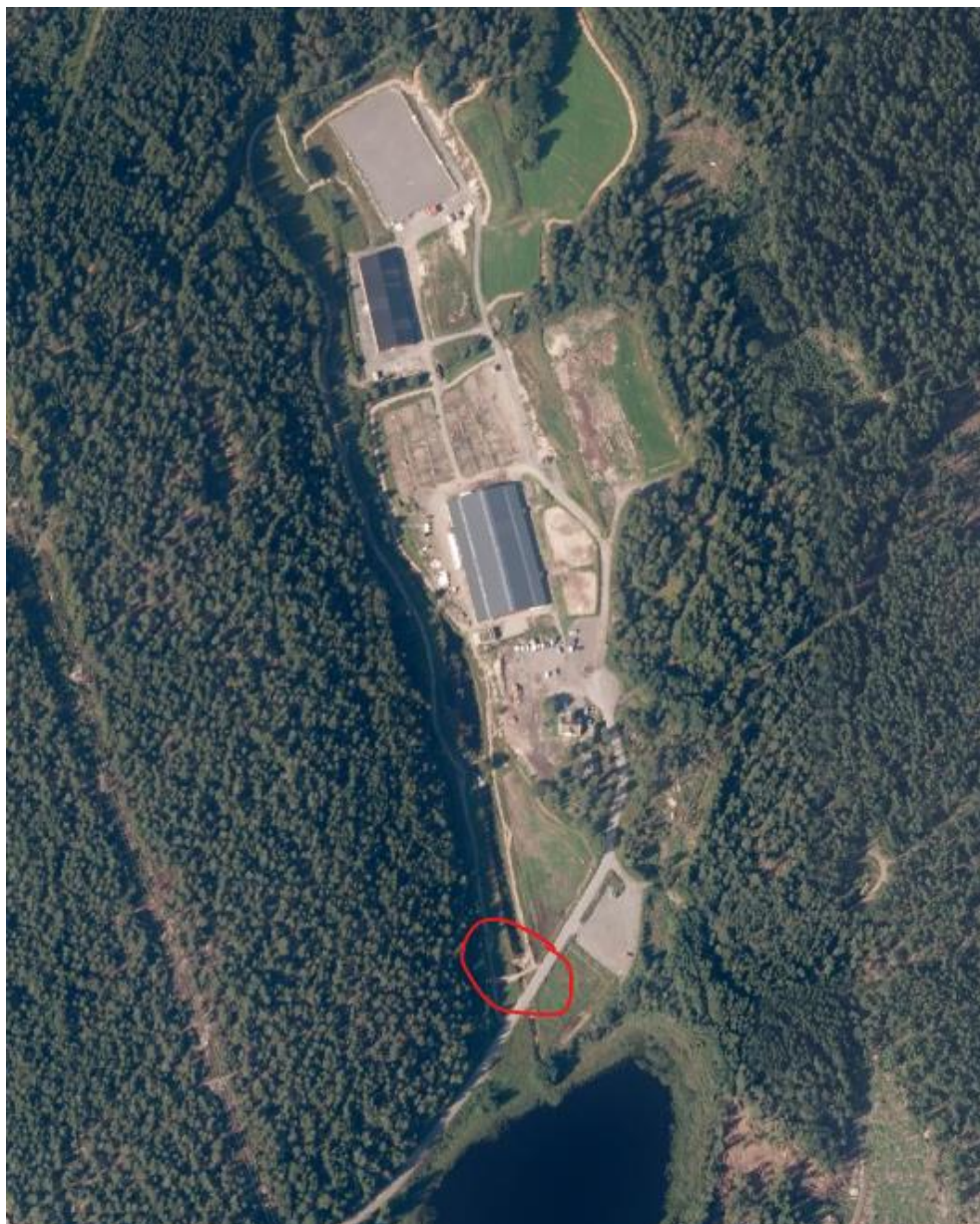
Figur V5-2: Utklipp av flyfoto tatt i 2010 fra området. Kilde: 1881.no. Med rød sirkel er markert en ny kulvert som ble etablert ca. 2009. I forbindelse med arbeidene skjedde et grunnbrudd, som ikke utviklet seg til et flakskred el. lign.
