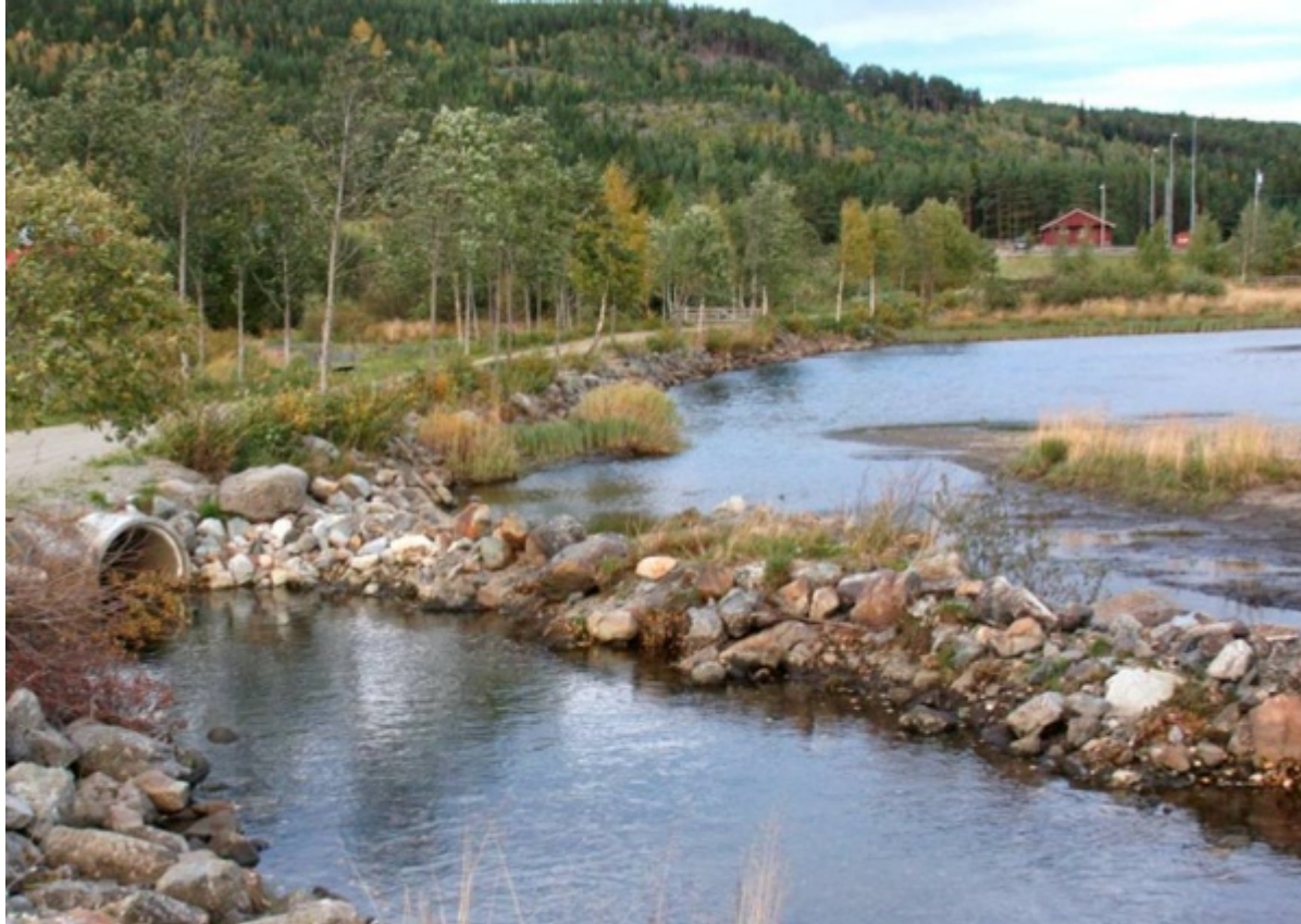
Figur 17: Eksisterende inntak ved Tveitahølen nederst til høyre. Vannføring er beregnet til ca. 19 m 3 /s. Foto 22.05. 2024, tatt fra nordøst mot sørvest. I bakgrunnen Storåne og E16. Lenast til høvre gårdsvei som skal legges om.
