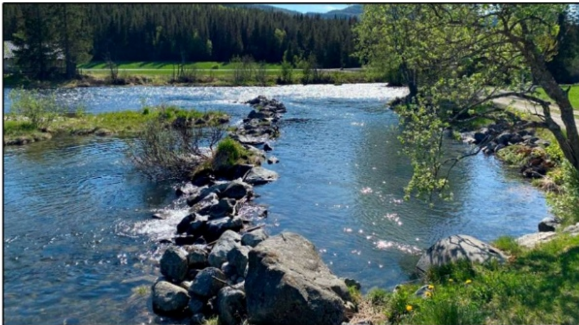
Figur 17: Eksisterende inntak ved Tveitahølen nederst til høyre. Vannføring er beregnet til ca. 19 m 3 /s. Foto 22.05. 2024, tatt fra nordøst mot sørvest. I bakgrunnen Storåne og E16. Lenast til høvre gårdsvei som skal legges om.
