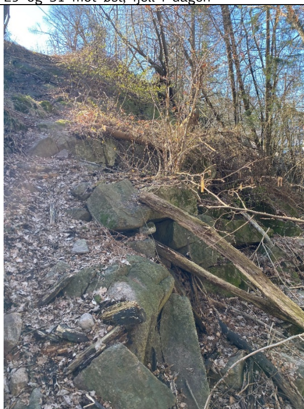
Bilde 10: Amundrødveien i østlig retning
