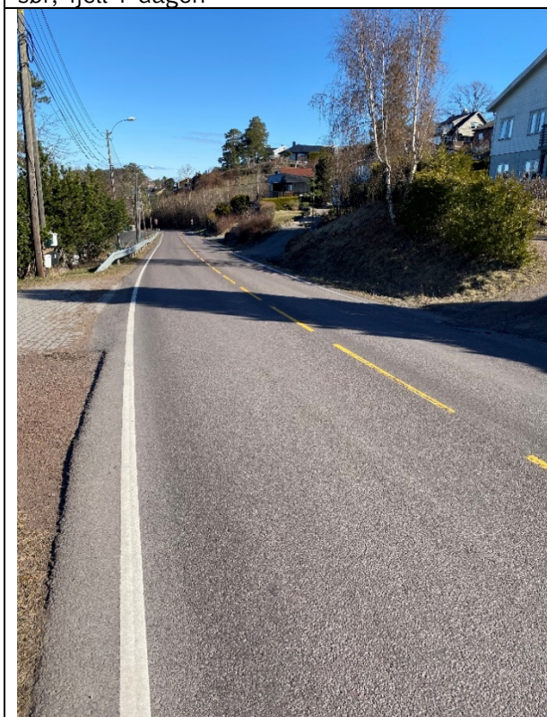
Bilde 9: mot Amundrødveien nr. 12 og 14, fjell i dagen i skråningen
