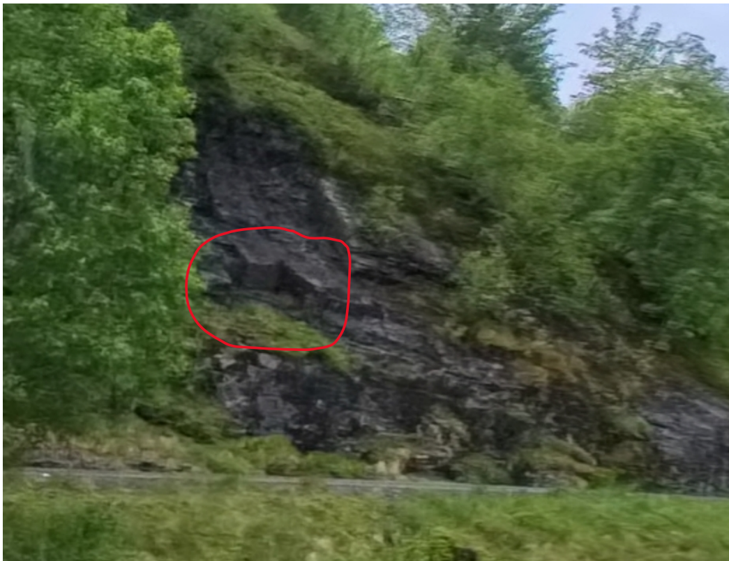
Figur 4-2: Skrent nærast vegen. Tre sprekkesett gir potensiale for danning av blokk.
