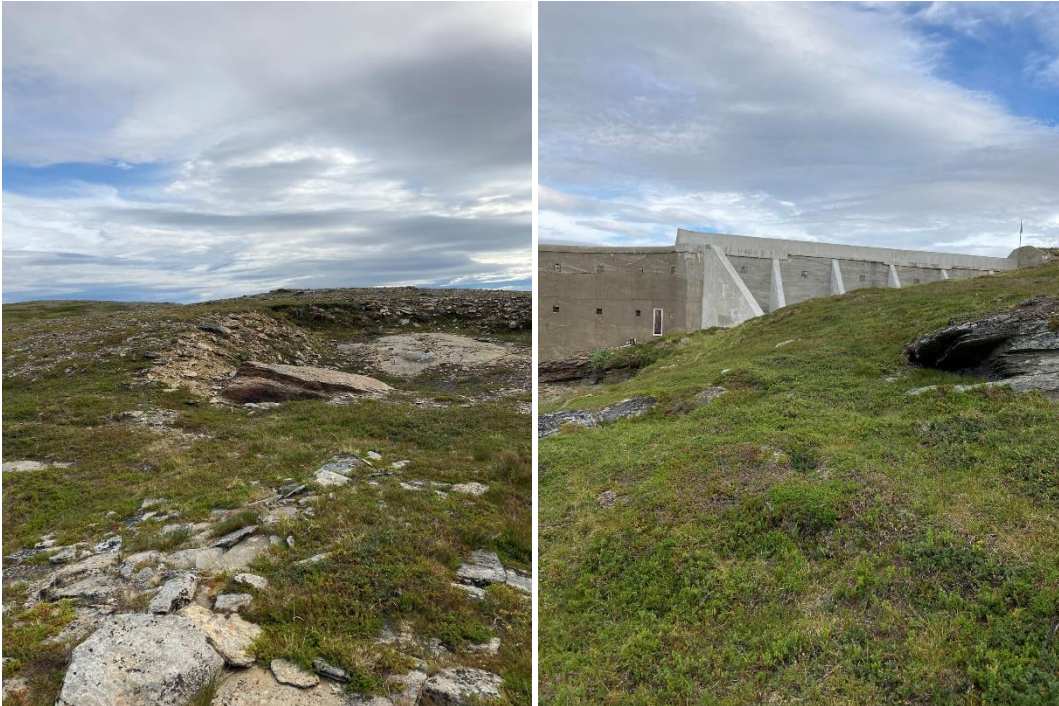
Figur 2-12 Bilde til venstre viser tidligere masseuttak innenfor inngrepsgrensen øst for dammen. Bilde til høyre viser terreng nedstrøms dammens østre vederlag. Foto: Sweco Norge, 2021.
