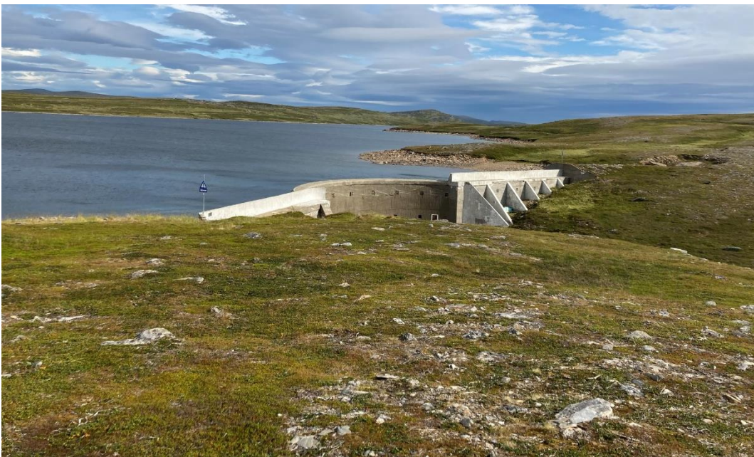
Figur 2-5 Oversiktsbilde av terreng fra vestre side. Området består av et relativt flatt parti med tynt løsmassedeckke. Foto: Sweco Norge, 2021.
