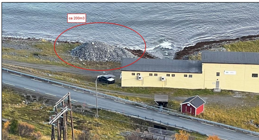
Figur 3-1 Bilder over tilgjengelige masser ved Repvåg kraftstasjon. Kilde: InfraNord.
