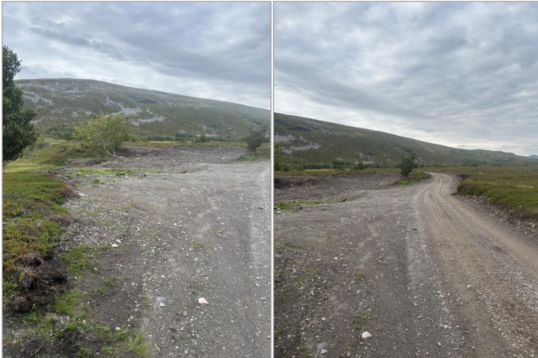
Figur 2-15 Bilder av massuttaksareal langs adkomstveien. Arealet omfatter et eksisterende massetak som ble utvidet for uttak av masser til utbedring av adkomstveien i 2023. Arealet er holdt åpent for eventuelt behov for ytterlige masseuttak i forbindelse med tiltak knyttet til ny dam Ørretvann. Det skal tilrettelegges for naturlig revegetering av området ved slutføring av tiltaket. Sweco Norge, 2025.
