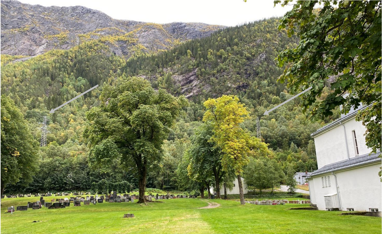
Figur 1-20. Eksisterende 132 kV ledningen Såheim-Mår går rett sør for Rjukan kapell. De grå pilene peker på mastene som skal rives. Bildet er tatt i retning sør.
