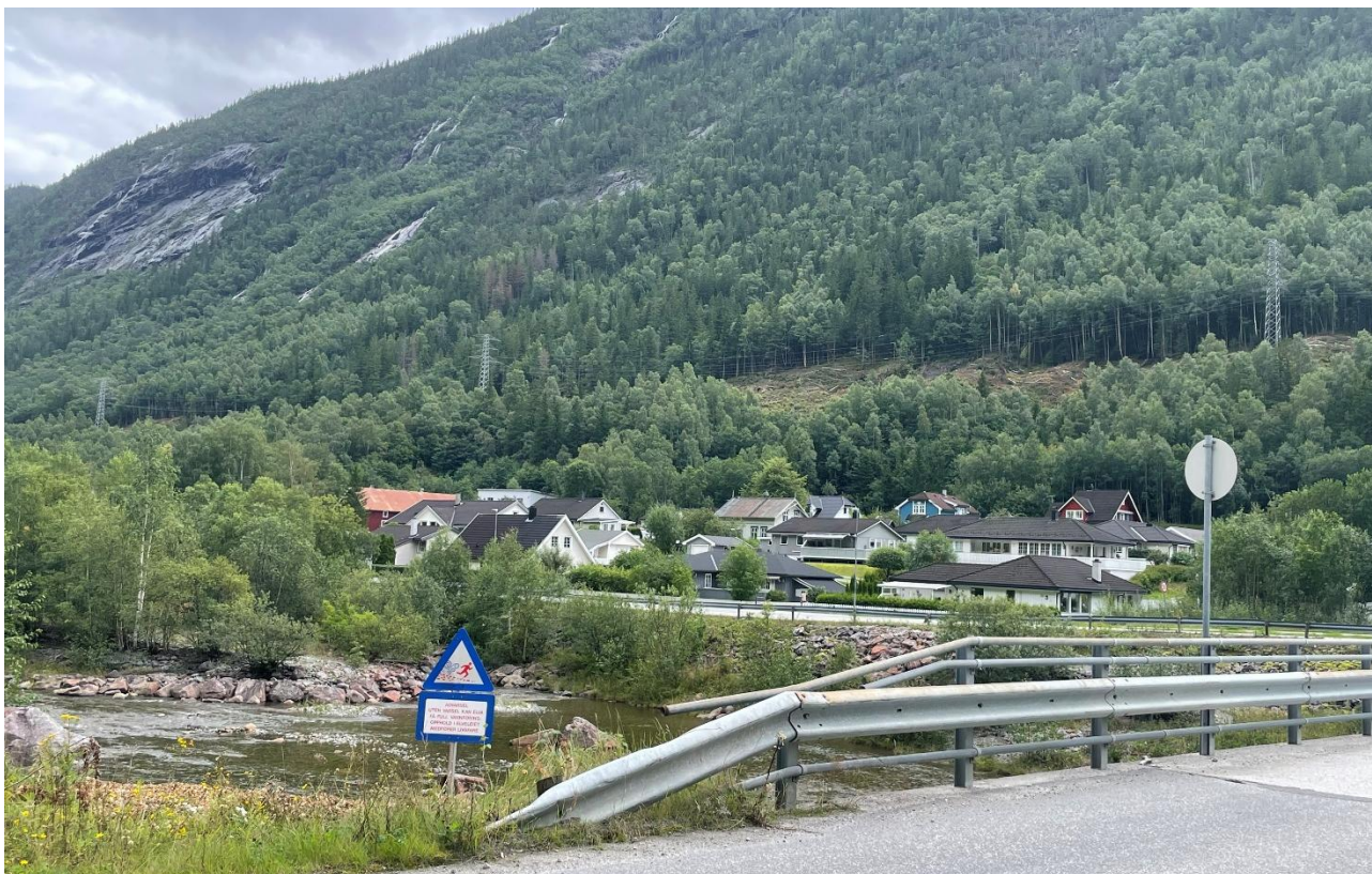
Figur 5-4: Eksisterende 132 kV-ledning Såheim – Mår er noe tilbaketrasket, men likevel godt synlig i den nedre dalsiden mellom Svadde og Dal, her sett fra der Svaddevegen krysser Måna.
