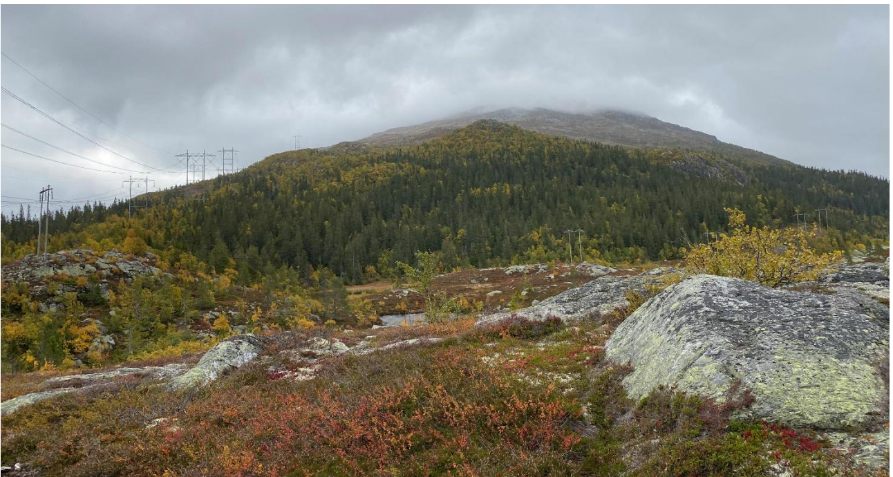
Figur 5-6: Fra Gaustabrotet nordvest for Gaustatoppen. Den eksisterende 132 kV-ledningen Såheim – Årlifoss, som sees i forgrunnen, skal rives.
