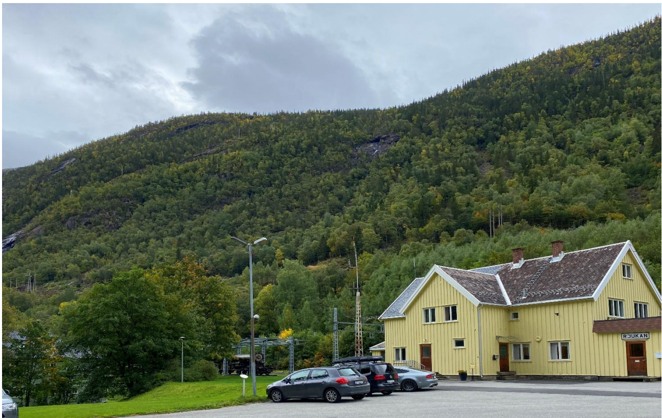
Figur 5-2: Eksisterende 132 kV-ledning Såheim - Årlifoss sett fra Rjukan stasjon kan skimtes i dalsiden. De nye ledningene vil spenne opp dalsiden til venstre for denne, men i langt spenn slik at det ikke blir stående master i lia.
