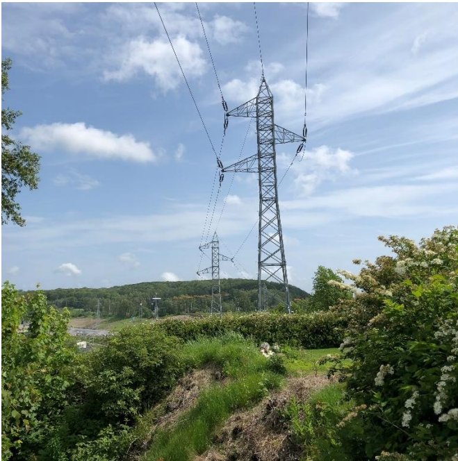
Figur 1-16. Bilde av tårnmast i stål med liner i vertikaloppheing.
