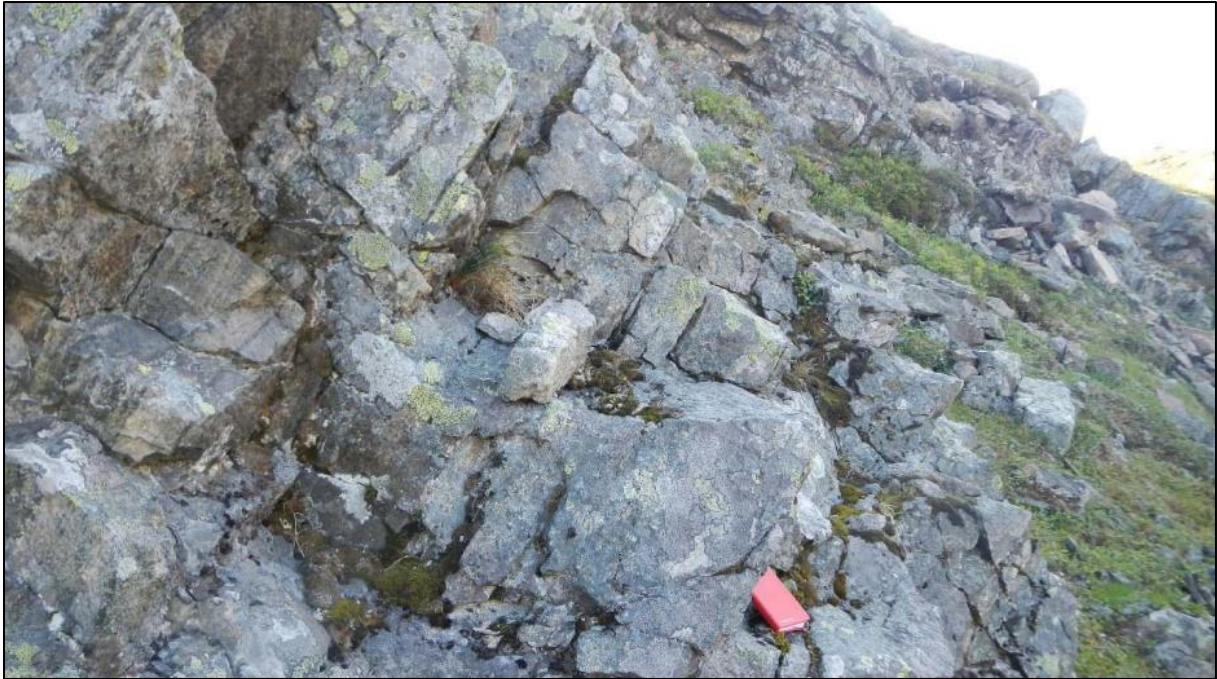
Figur 6.1-5: Bilde mot sør, viser oppsprekkingsgrad av gneisen i kraftstasjonsområdet. Hentet fra Multiconsult (2015), deres lok 12 (nøyaktig hvor i kraftstasjonsområdet bildet/skrenten er plassert er ikke mulig å gjenfinne ut fra rapportens beskrivelser). Vi har anslått bildelokasjon i denne rapporten, som er vist som infopunkt 5 i registreringskart.
