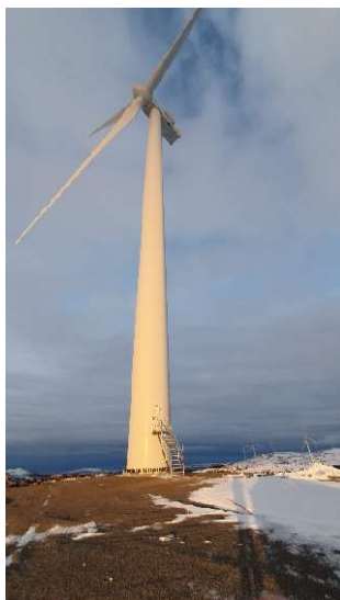
Figur 6: Vindturbin G02 i Hitra 2 vindpark. Målingene i vindparken ble utført i området rundt denne turbinen.
