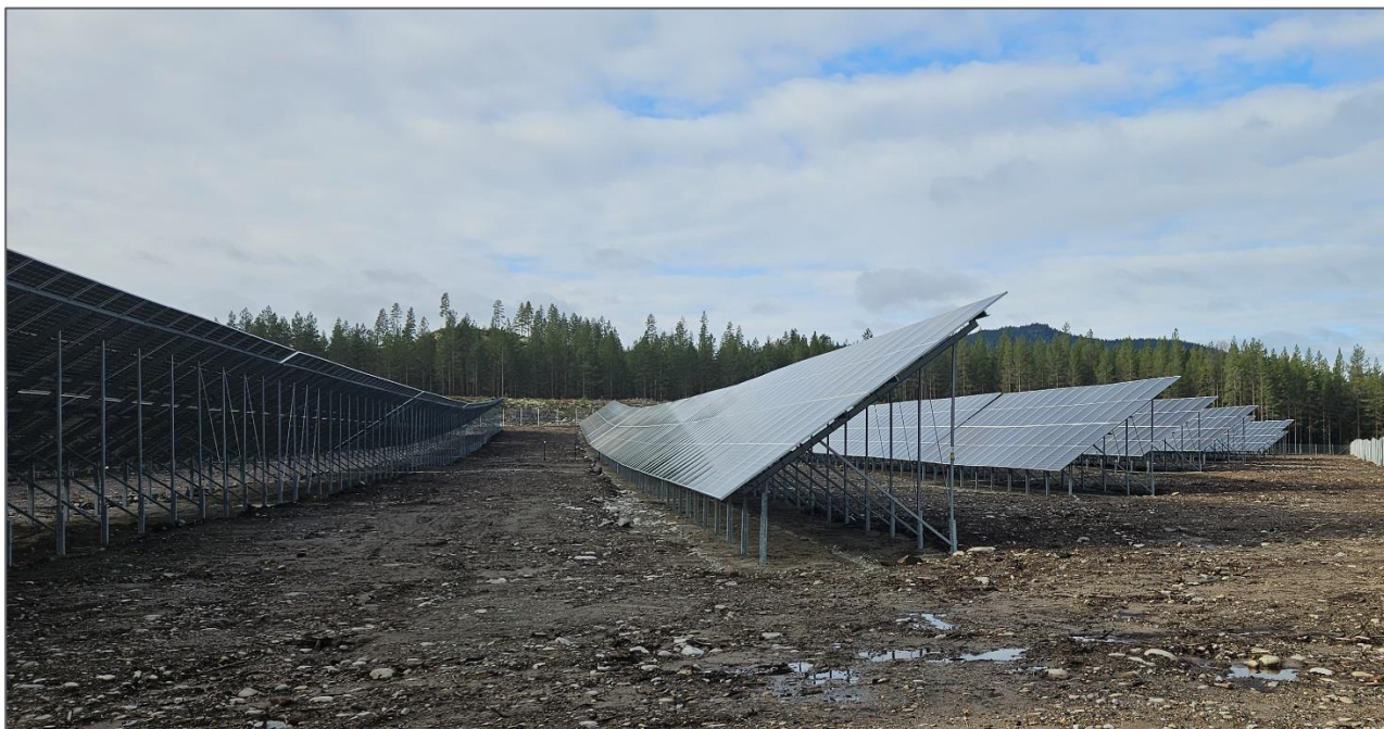
Figur 3-3: Fast-vinkel installasjonsløsning.
