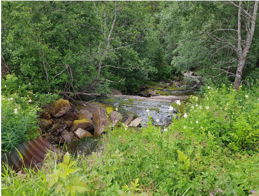
Figur 1: Fossen like nedstrøms kulverten gjennom veien. Fjell i dagen.
