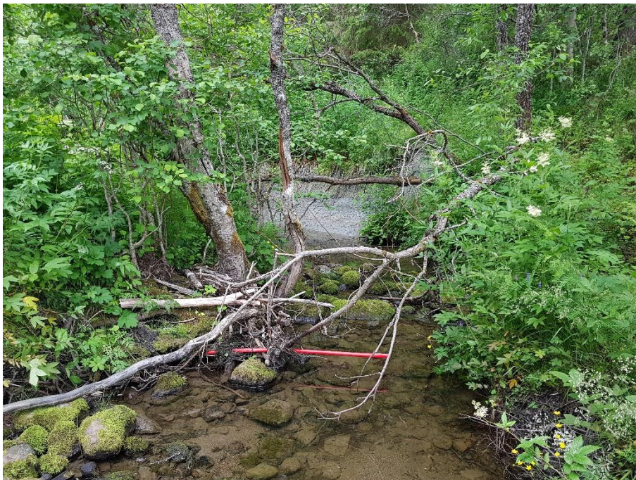
Figur 4: Erosjon i yttersving ved gammel grop.
