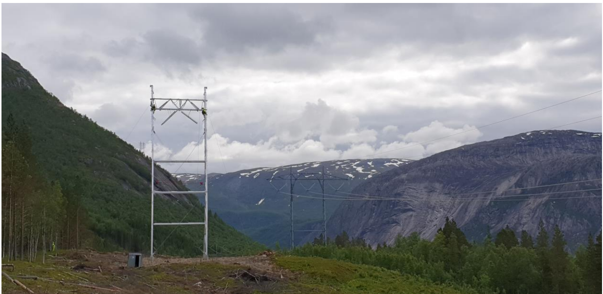
Figur 3-36. 420 kV aluminiummast under bygging nær Kobbvatnet transformatorstasjon til venstre i bildet og eksisterende stålmast til høyre. Stålmaster med mer matt overflate og en nyanse som er mer ton i ton med et typisk naturlandskap vil gli bedre inn i omgivelsene. Foto: Statnett.
