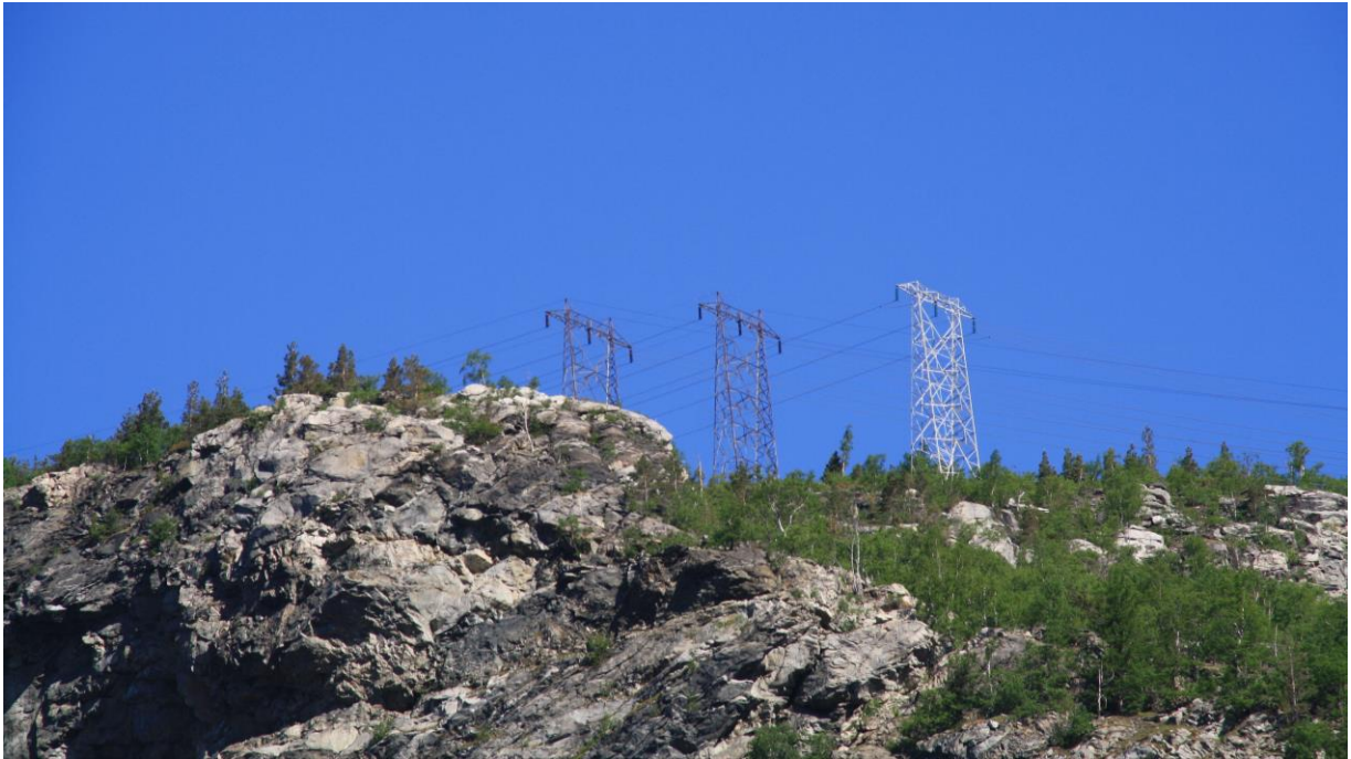
Figur 3-37. 132 kV master (Fortun -Øvre Årdal). Aluminiummasten til høyre er mer fremtredende i landskapet enn de to stålmastene til venstre, spesielt med blå himmel i bakgrunnen. Foto: Statnett.
