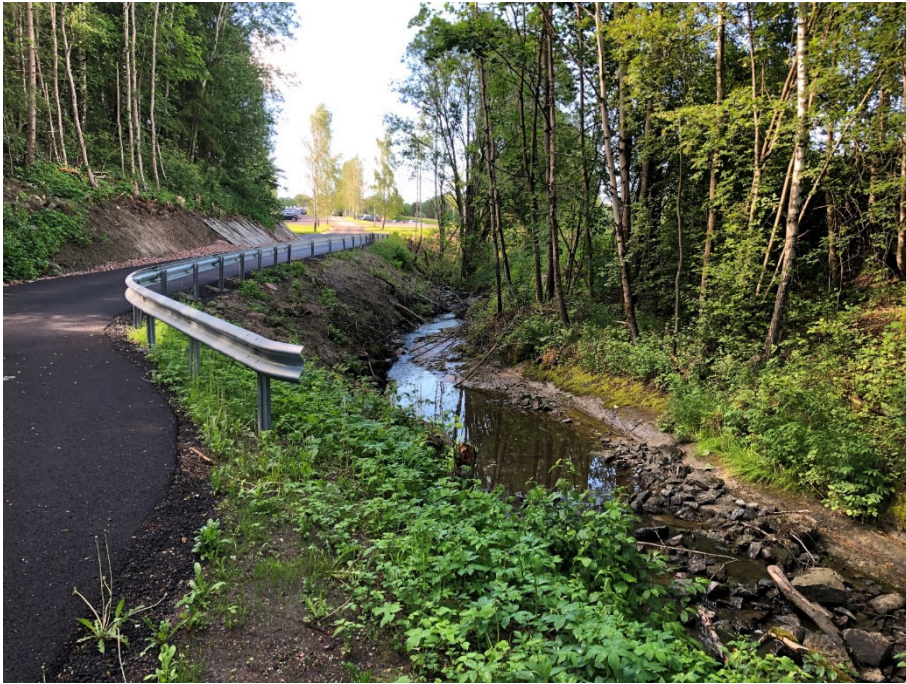
Figur 11. B16, registrert berg i dagen langs bekken mellom profil B-B og D-D.
