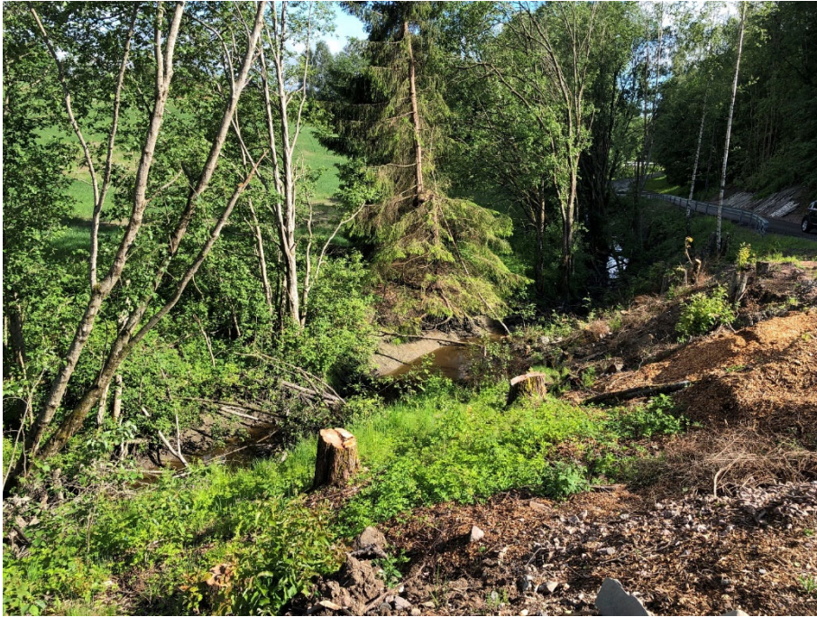
Figur 9. Bilde B3, bekken litt sør for profil A-A, sett fra vestre bekkekant ved golfbanen.
