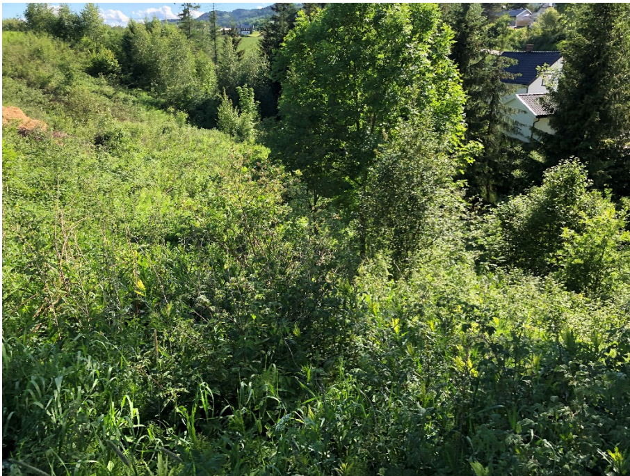
Figur 12. B22, bekkeskråningen mellom profil B-B og F-F.
