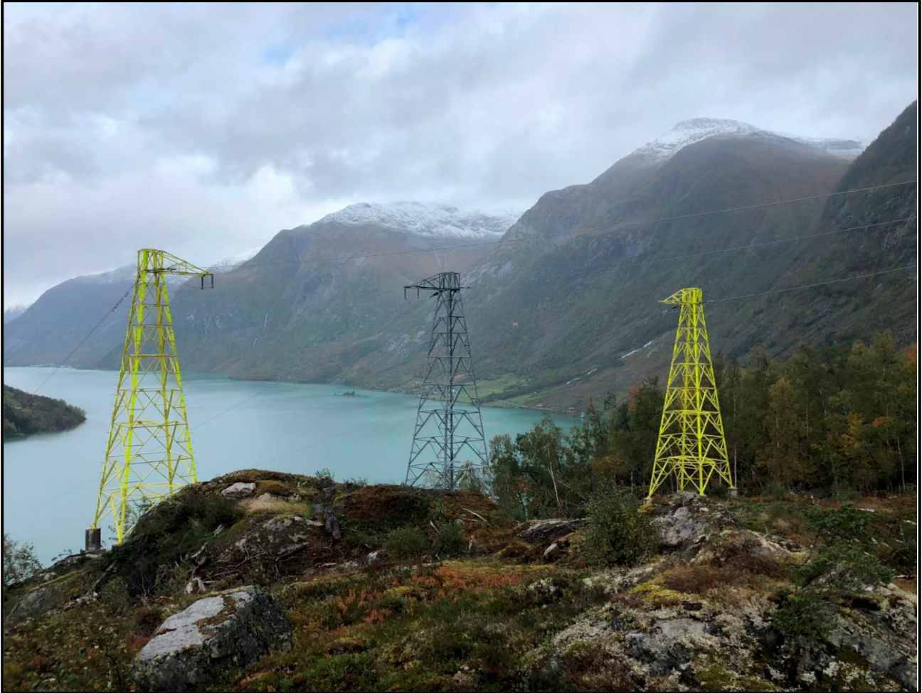
Figur 4-5: Typisk fjordspennmast med spennbukker for 132 kV-linje.
