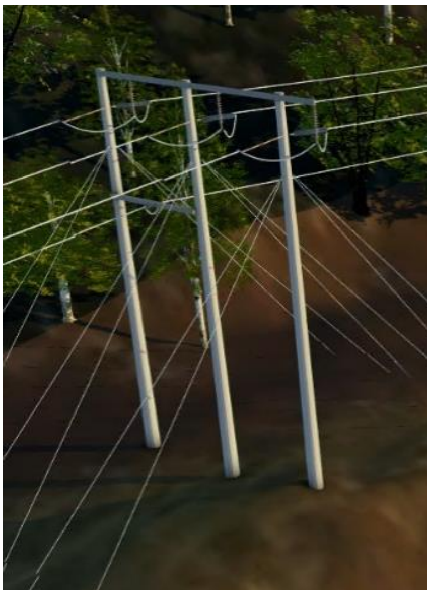
Figur 4-2: Visualisering av H3 bardunert vinkelforankringsmast.
