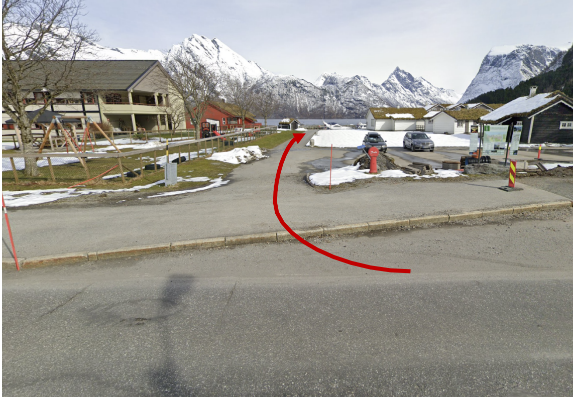
Figur 3 Veg for transformatortransport ønskes etablert på gang- og sykkelvei og over parkeringsplassen.
