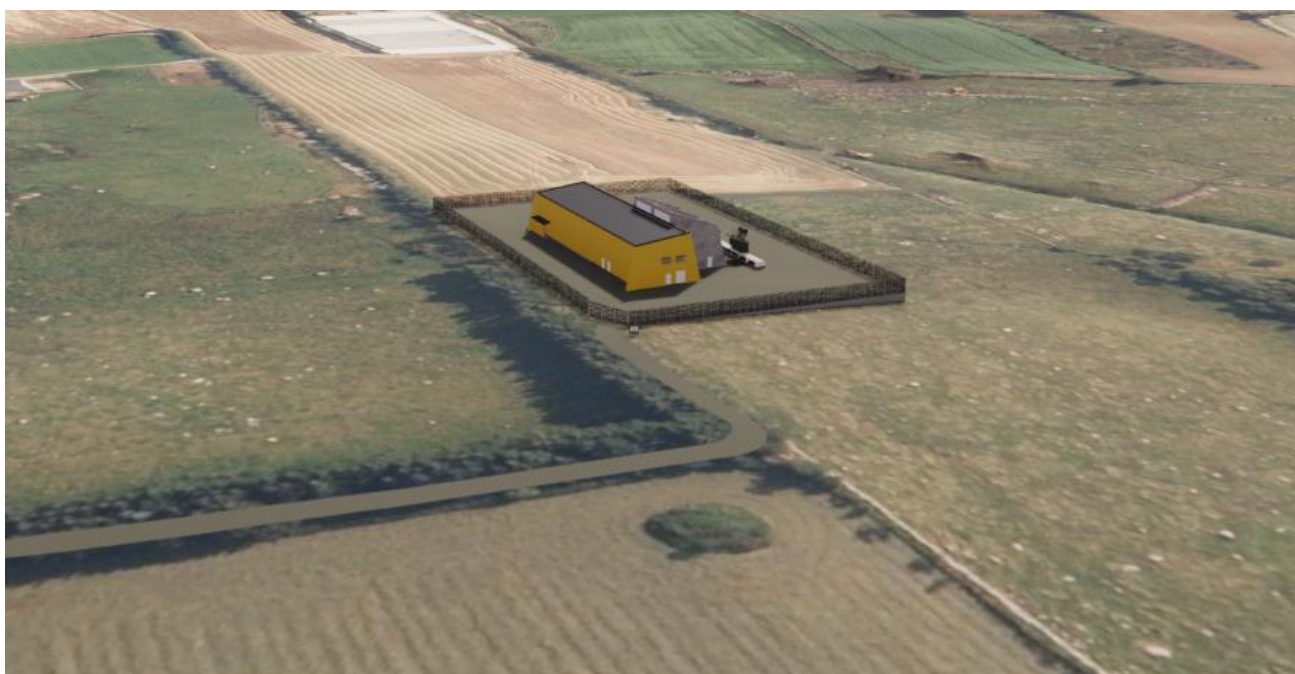
Figur 4 Tjøtta transformatorstasjon - sett fra vest
