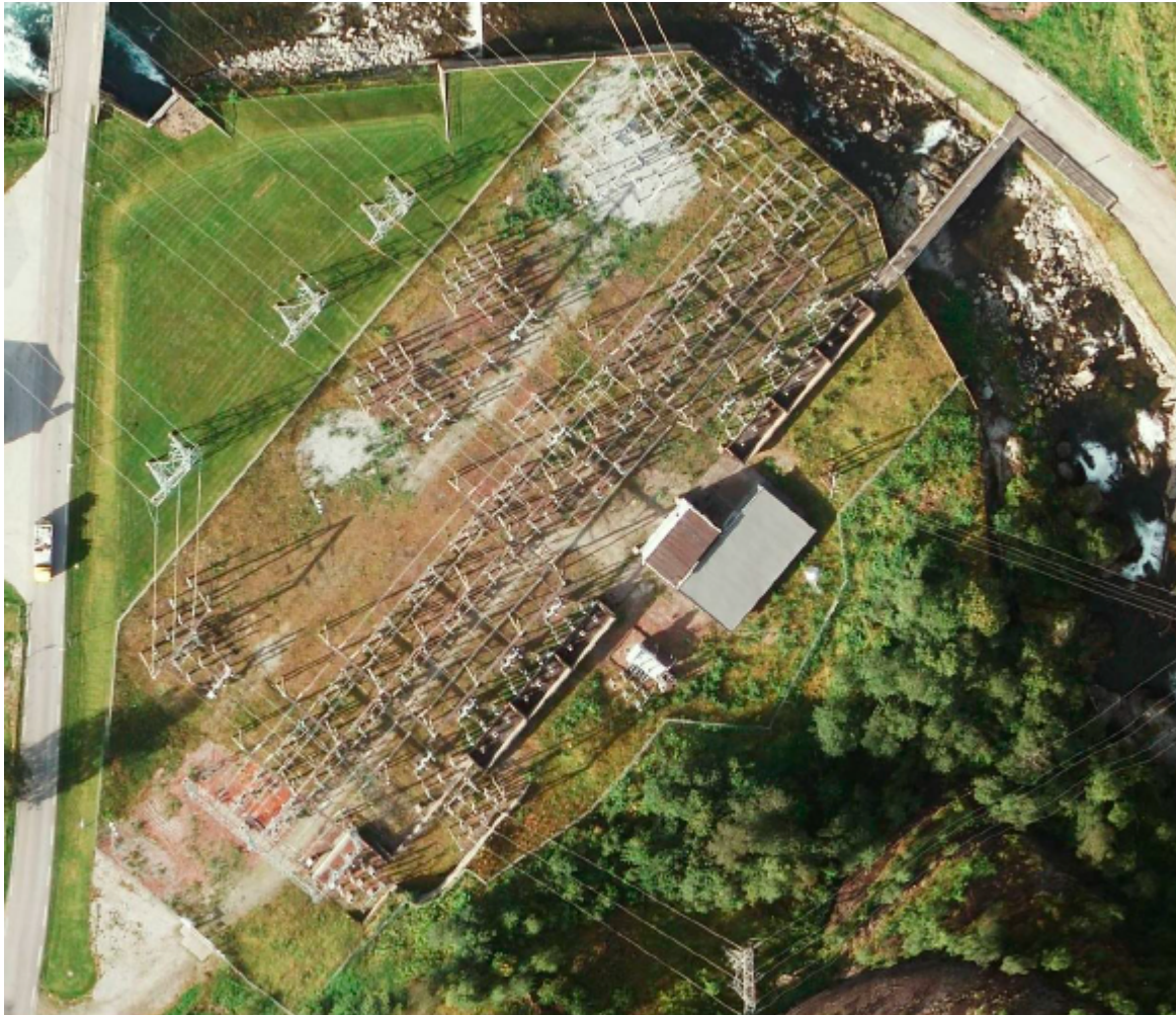
Flyfoto 1: Inngjerdet areal Fortun transformatorstasjon
