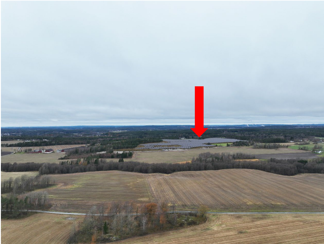
Figur 3-4: Viser fotomontasje av solkraftverket sett fra øst.
