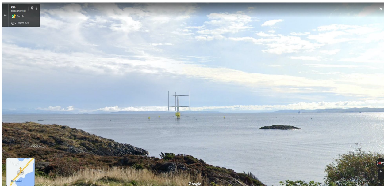
Figur 21. Utsikt til turbinen fra E39 i samme siktlinje - som nærmeste fritidsbolig (og med zoom). Fritidsboligen ligger noe høyere og lengre fra veien (se figur 4, side 14), så utsikten derfra blir mer ovenfra, og demper derfor den visuelle effekten noe sammenlignet med denne illustrasjonen.
