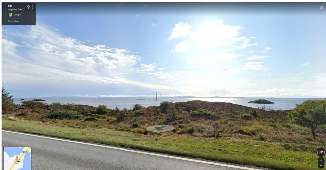
Figur 20. Utsikt fra E39 mot installasjonen
