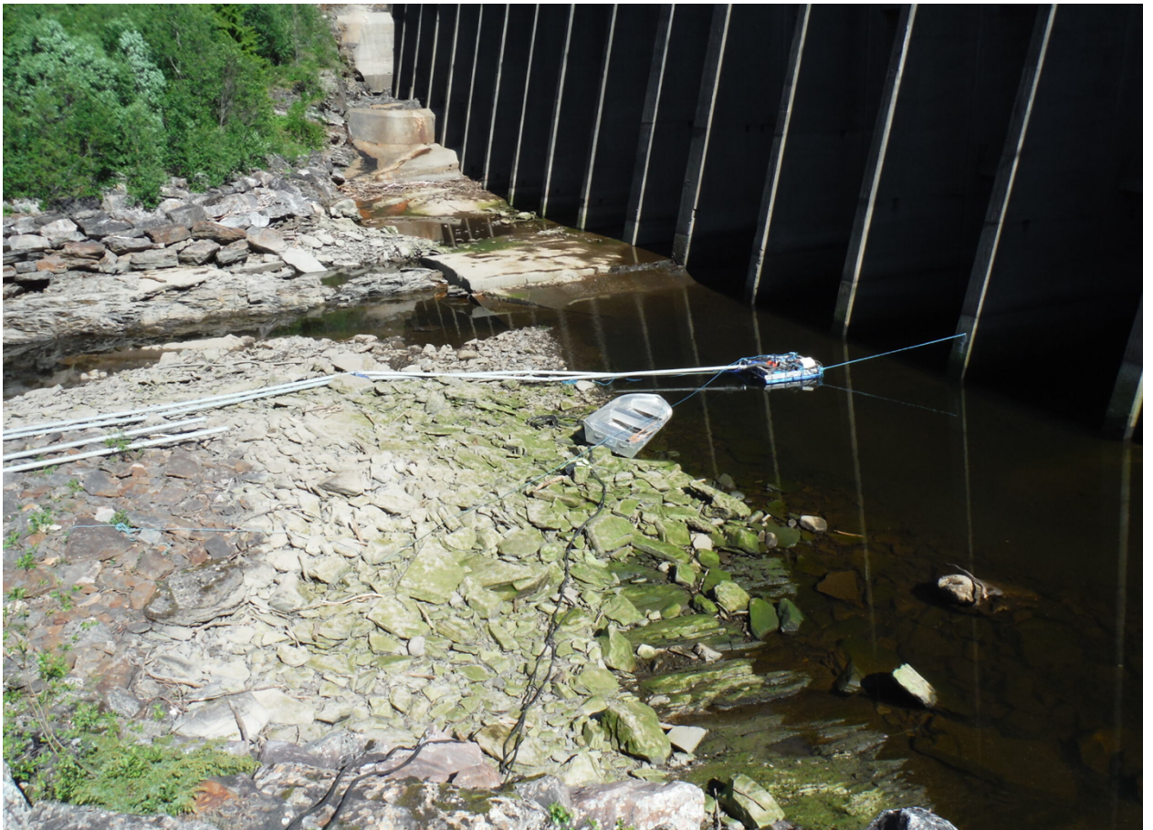
Figur 5 Senkning av vannspeil.
