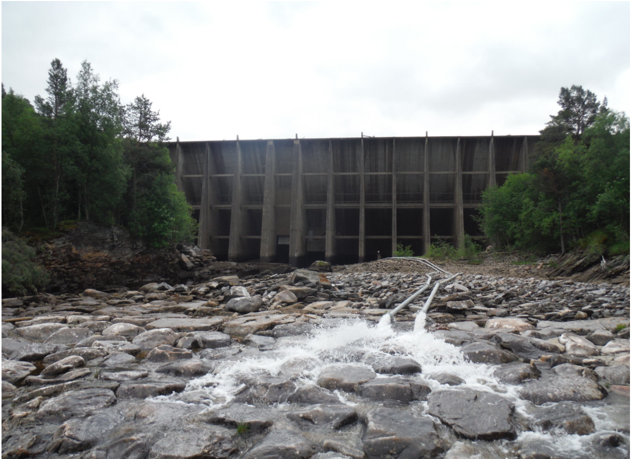
Figur 3 Tidligere senkning av vannspeilet.
