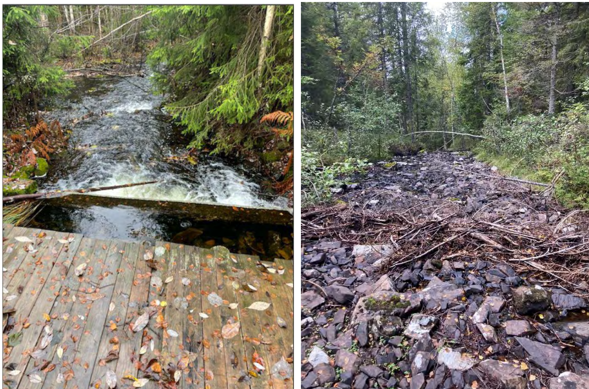
Figur 3-13. Bilder av Røbekken. Bilde til venstre er tatt under en flomsituasjon med et overløp over dammen på ca. 300 l/s (basert på 6.10 Gryta). Bilde til høyre ble tatt under befaring tidligere på høsten, under en normal til tørr situasjon. Foto: T.v.: Hurdal kommune, 31.10.2022. T.h.: Sweco, 14.09.2022.
