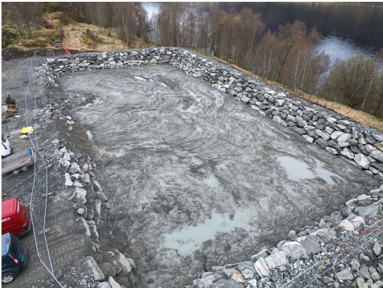
Figur 6-3: Deponi etter ferdig masseutskiftet kvikkleire.
