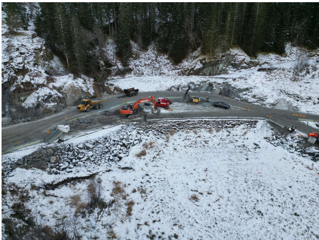
Figur 3-3: Etablert omkjøringsveg Bilde 30.11.2023.
