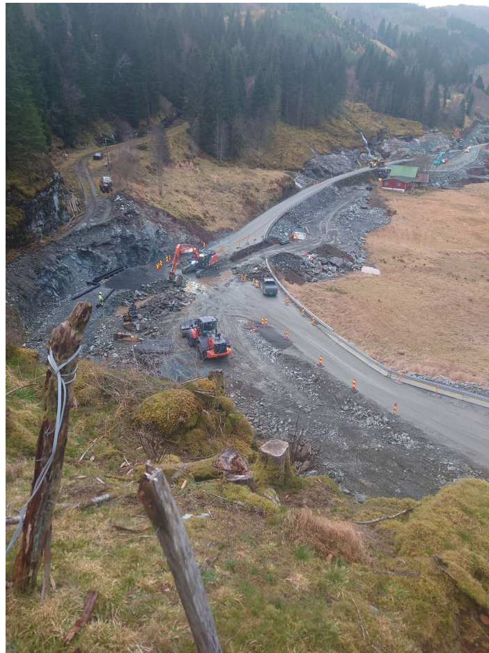
Figur 3-2: Bygging av omkjøringsveg, 02.11.2023.
