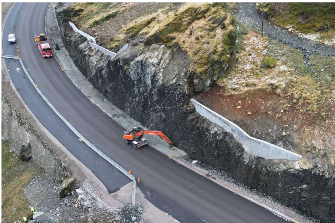
Figur 6-4: Gjenbruk av masser i grøft
