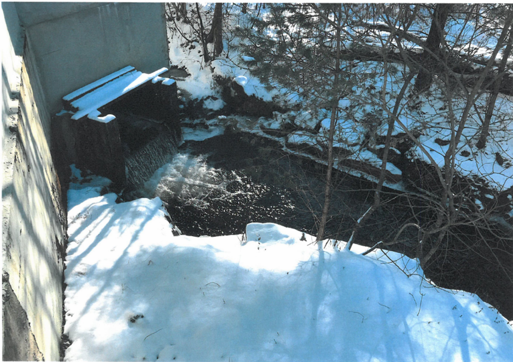
Utløp etter kraftstasjon Årskog
