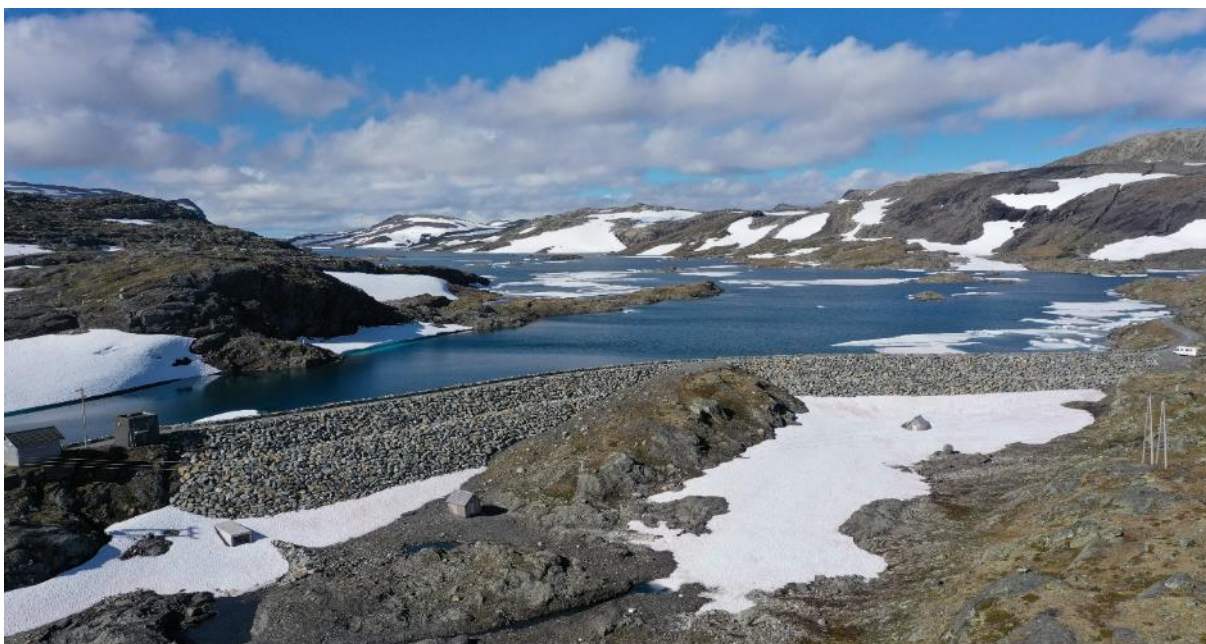
Figur 17 Dam Store Vargevatn – hoveddam. Flomløpet er rett utenfor venstre bildekant.
