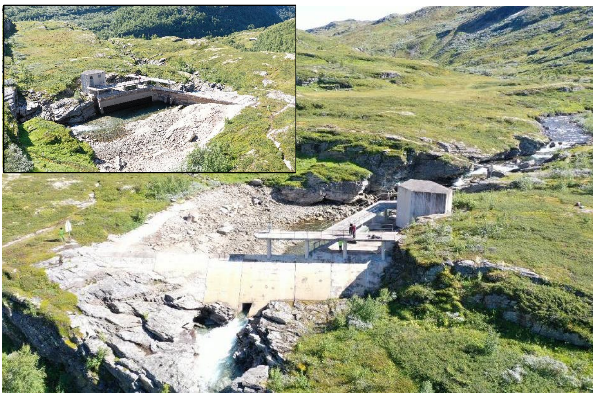
Figur 10 Inntak Grøna. På innfelt bilde sees inntaket fra oppstrøms side- og Aurlandsdalen øverst i bildet.
