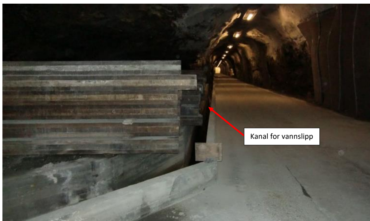
Figur 45 Tunnelpåhugg Njuken-Aurland 2 med kanalen forintervannslipp ved siden av veibanen
