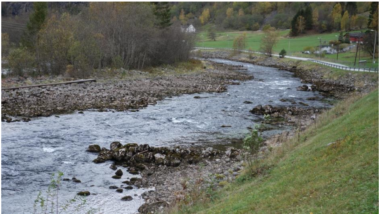
Figur 79 Utsnitt av Aurlandselvi ved vannføring på ca. 4 m 3 /s
