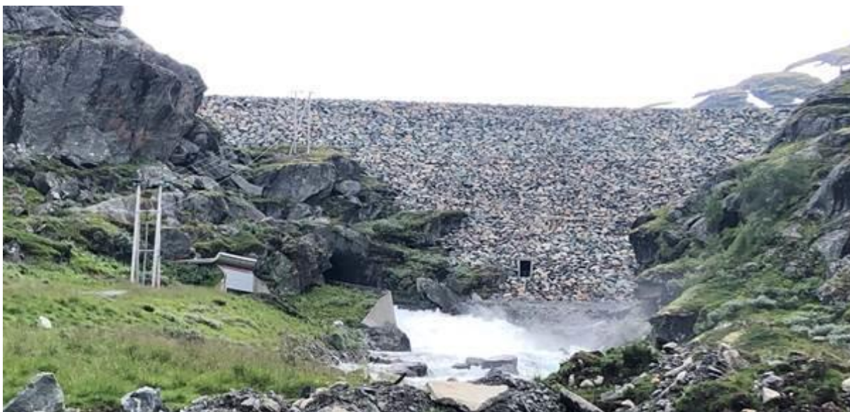
Figur 12 Dam Vetlebotnvatn etter rehabilitering
