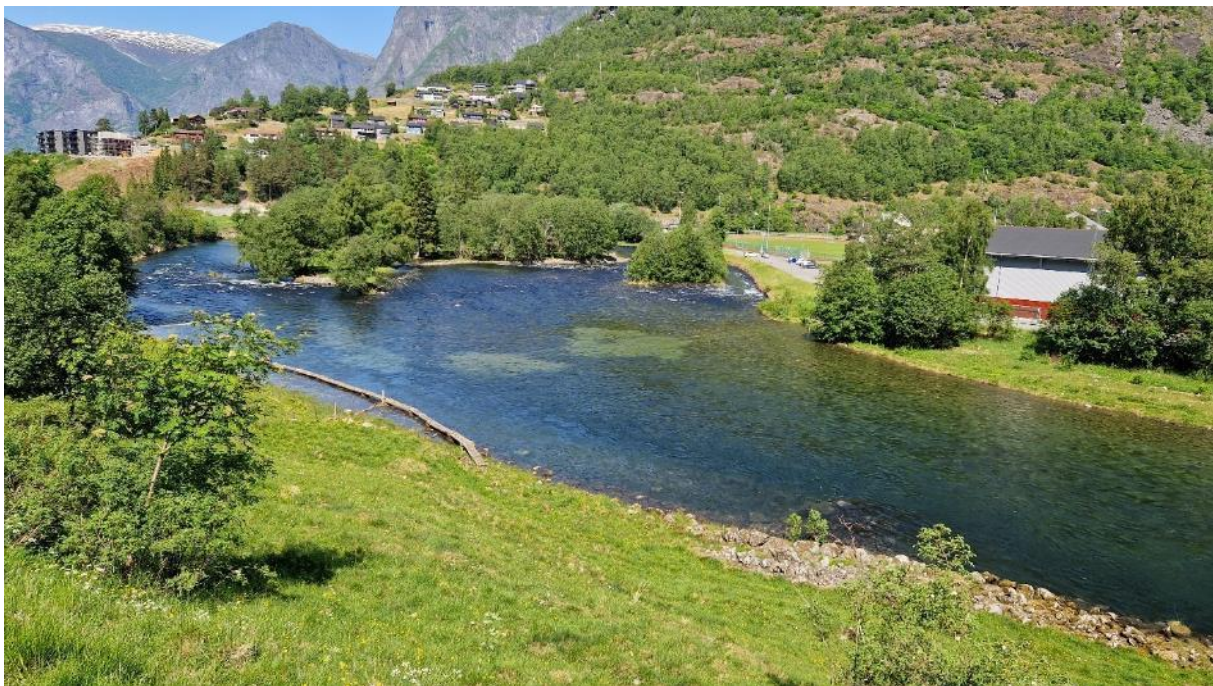
Figur 80 Aurlandselvi ved idrettshallen, ved en vannføring på ca. 34 m 3 /s. Lyse felter i elvebunnen er steder hvor det er lagt ut gytegrus.
