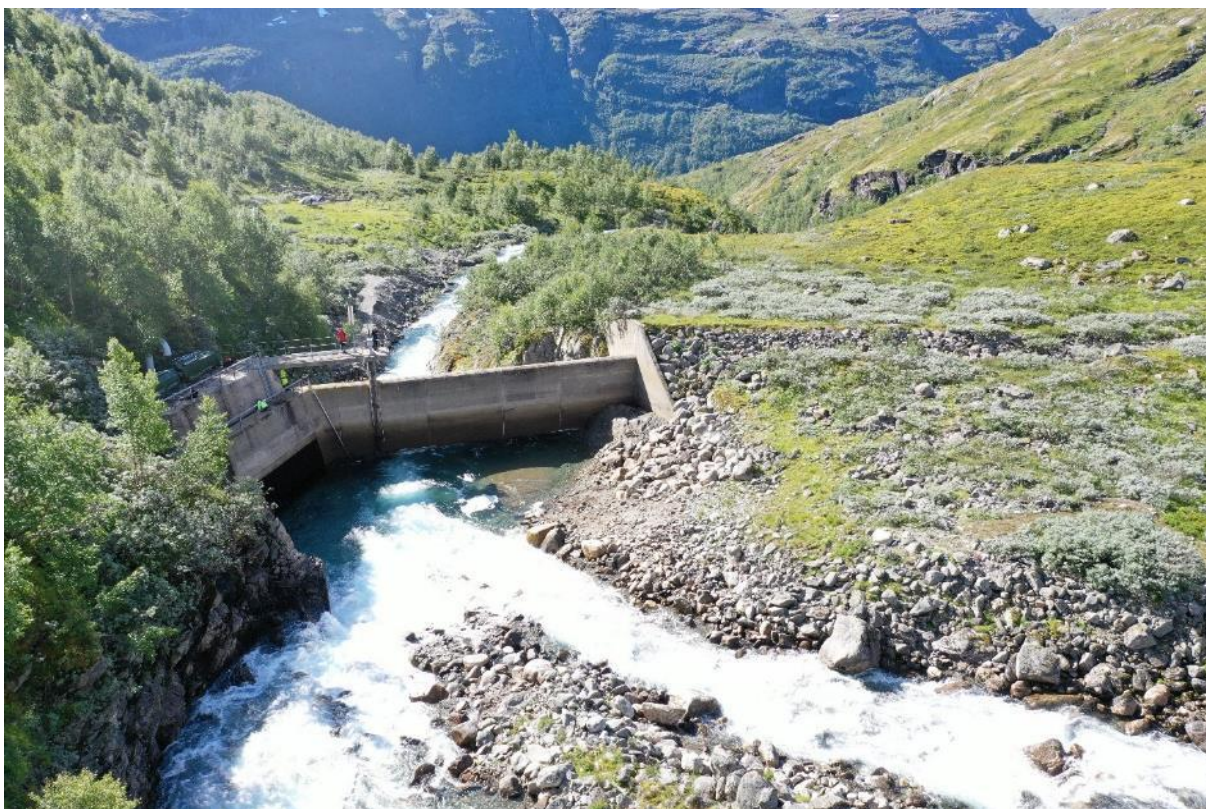
Figur 9 Inntak Langedøla. Østerbø, som er utgangspunkt for fotturen gjennom Aurlandsdalen, ligger i dalbunnen nedenfor.
