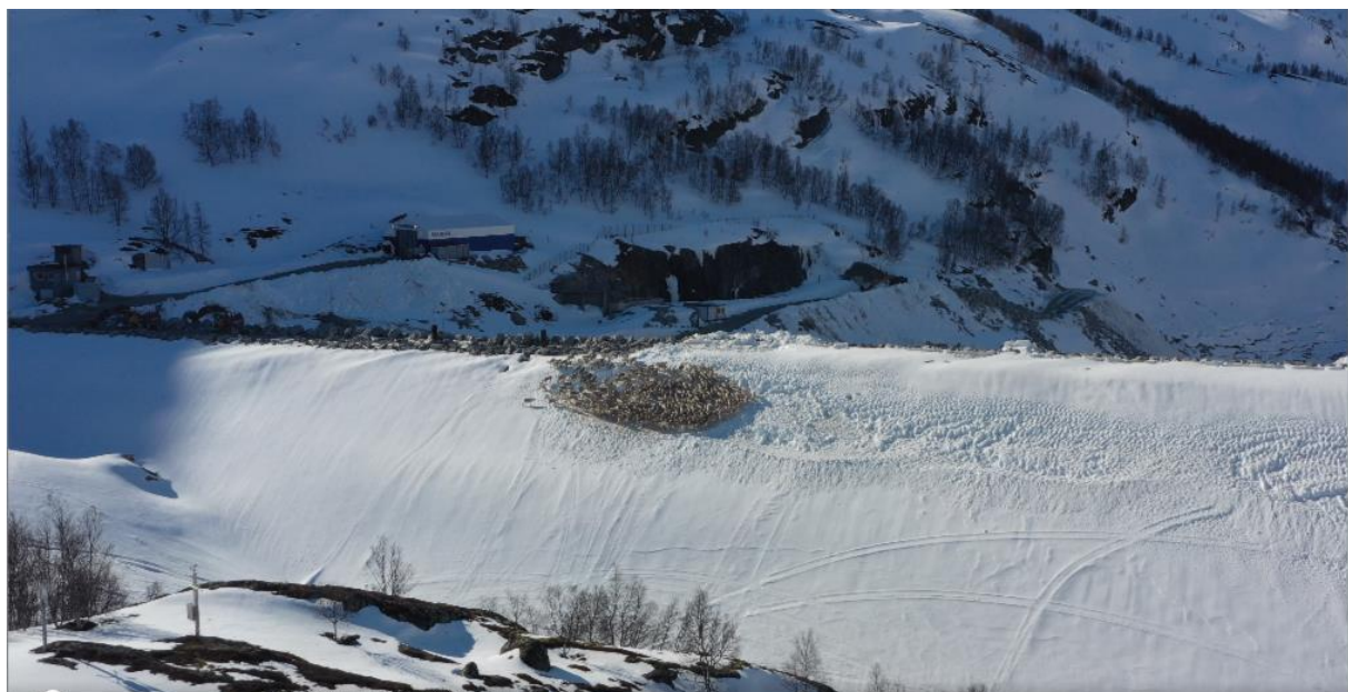
Figur 84 Villrein passerer Viddalsdammen 20.04.2023. Anleggsarbeidet ble midlertidig stanset.
