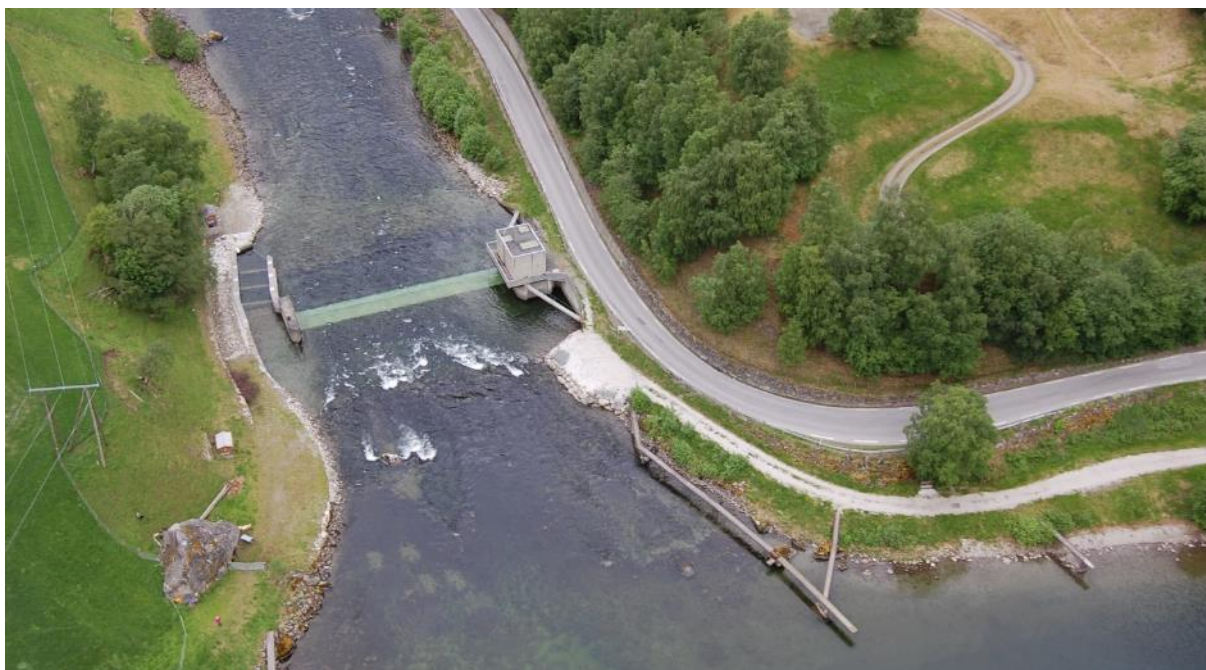
Figur 81 Reguleringsluke (senket/åpen) og fisketrapp (venstre side) i utløpet av Vassbygdvatn
