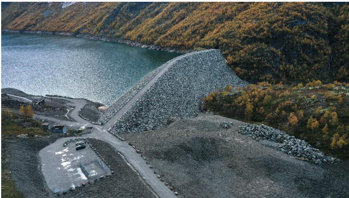
Figur 22 Dam Viddalsvatn rett etter at rehabiliteringen var ferdigstilt høsten 2023.
