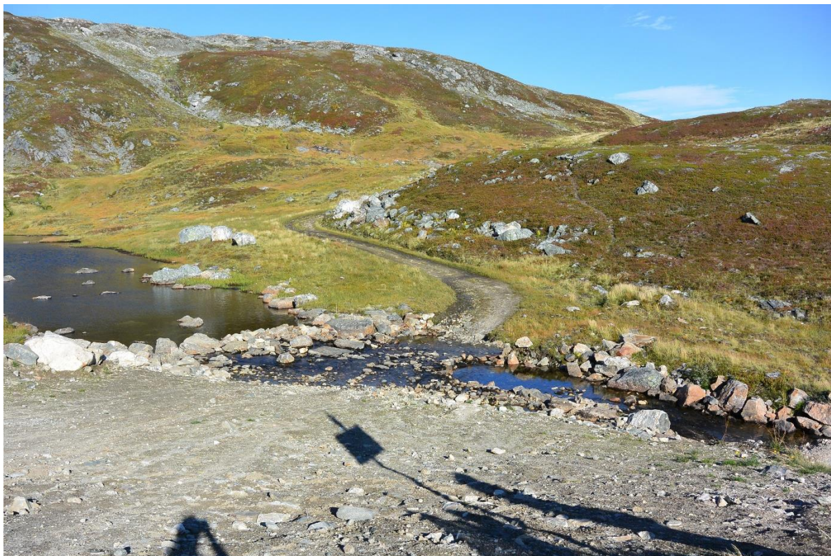
Figur 3-23: Eksisterende situasjon ved adkomstvei fra Nedrevatn til dam Amundvatn. Bildet er tatt i retning nord.
