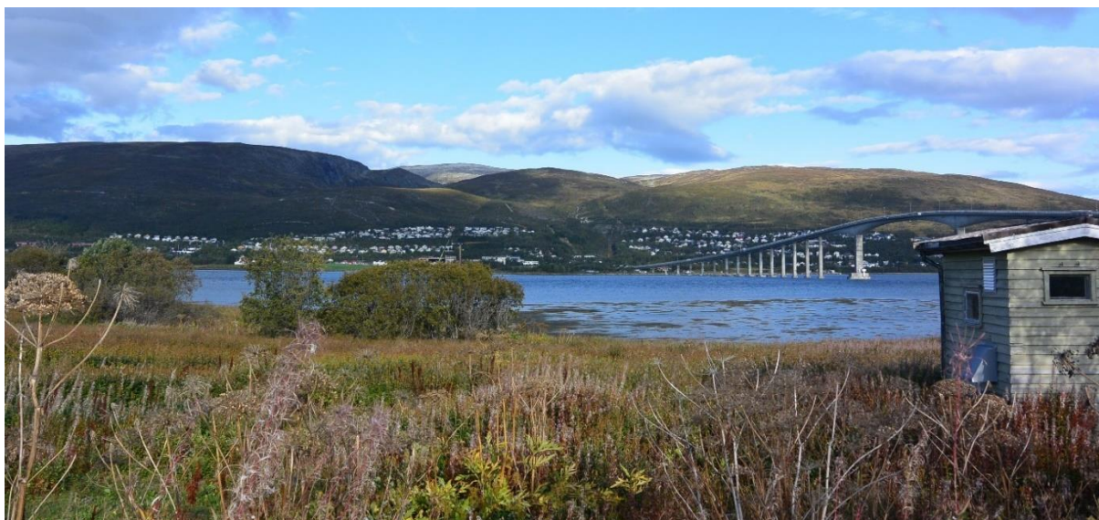
Figur 3-25: Foto fra Grindneset som viser dagens situasjon for eksisterende veitrase opp til dammene.
