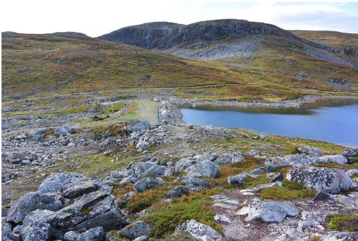
Figur 3-18: Eksisterende situasjon ved dammen for nedre Svarthammervatn. Bildet er tatt i retning sør.
