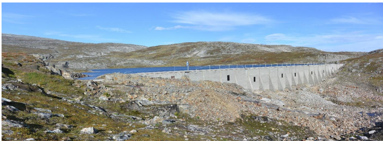
Figur 3-20: Panoramafoto av eksisterende situasjon ved dam Amundvatn.
