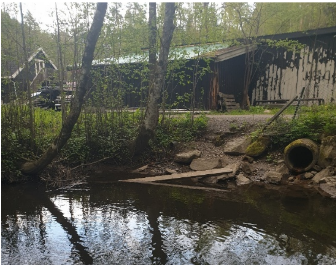
Tiltak ved Storeåsen er planlagt rett til venstre for betongrør.
