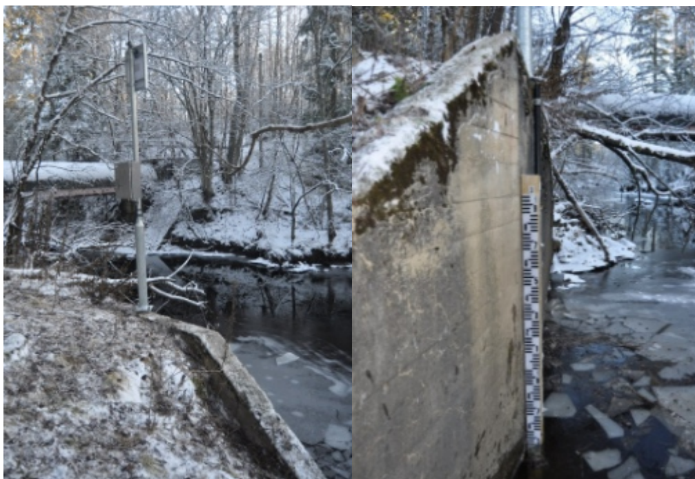
Eksempel på målestasjon for minstevannregistrering med vannstandsskala (Heggelielva).
