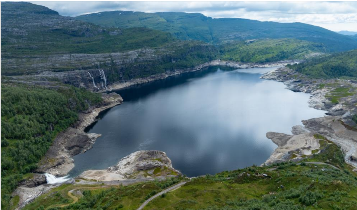
Figur 1-4. Bilde av reguleringsmagasinet Kvitingvatnet tatt fra nord mot sydvest. Dagens kraftverksutløp er til venstre i bildet. Bilde: Sweco.
