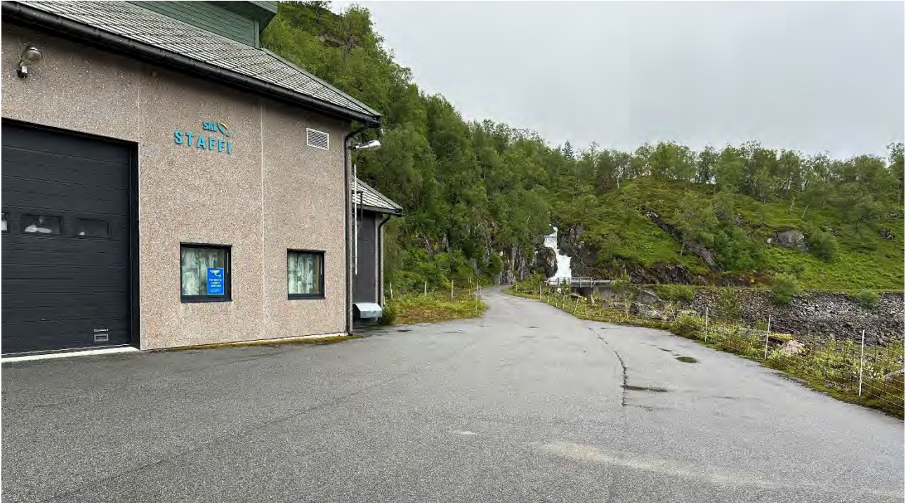
Figur 3-28. Område ved Staffi kraftstasjon som er opparbeidet fra før av.
