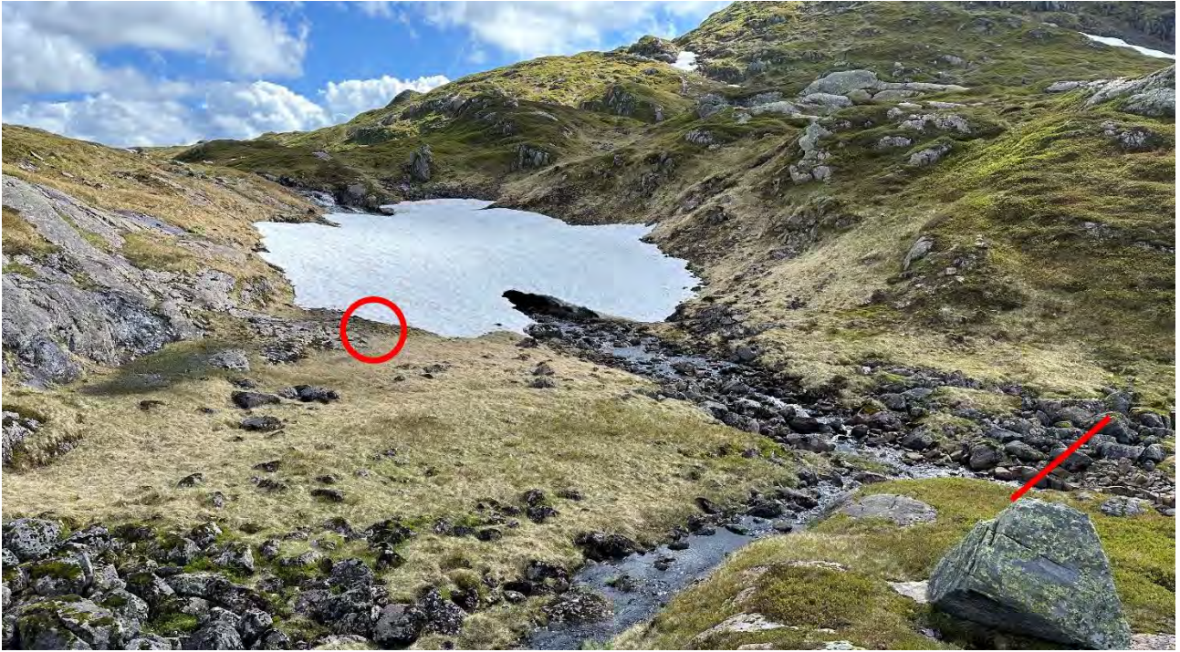
Figur 3-10. Bekkeinntak Verahaugen. Inntak er markert til venstre og sperredam til høyre.
