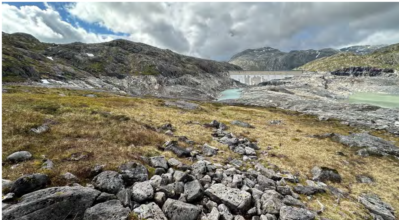
Figur 3-22. Bilde tatt fra område der det skal anlegges rigg i forbindelse med boring av lukesjakt.
