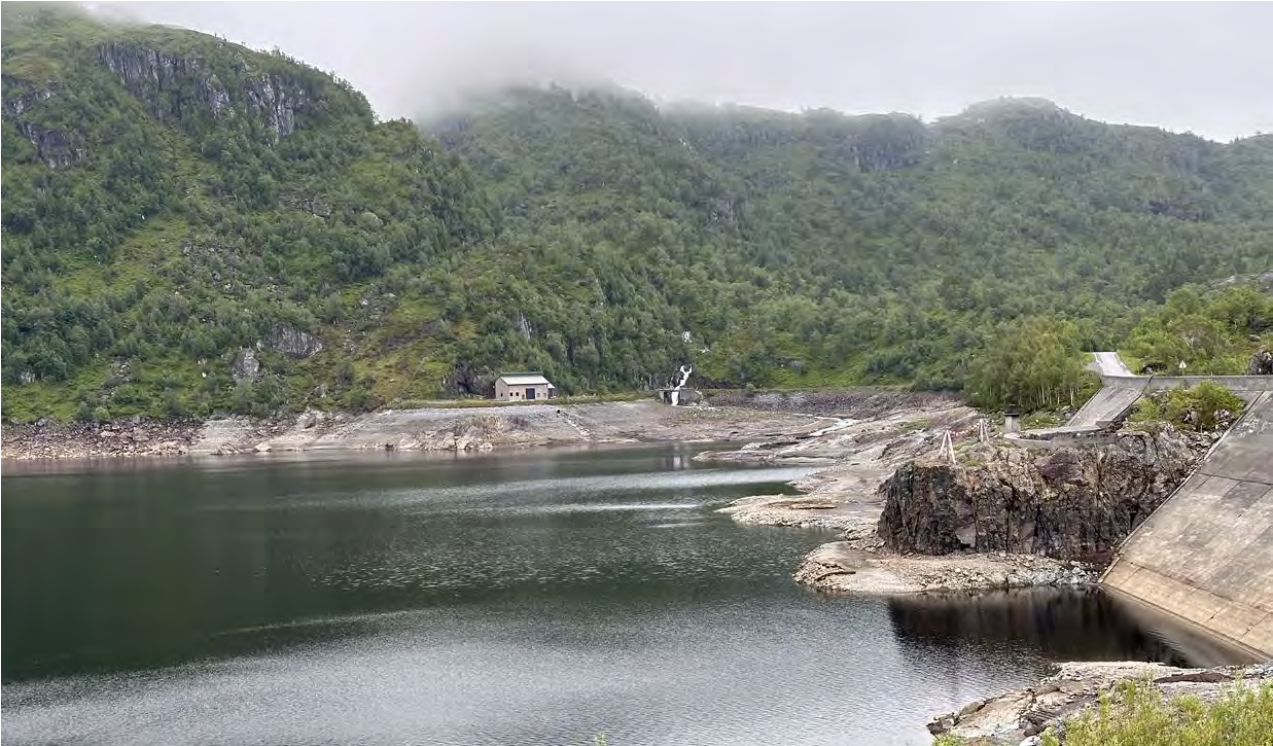
Figur 3-17. Dagens situasjon ved Staffi kraftstasjon. Nytt portalbygg plasseres til høyre for kraftstasjonen i bildet.
