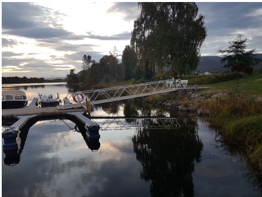
Figur 6. Bilde B5 fra befaring 22.09.2021.
