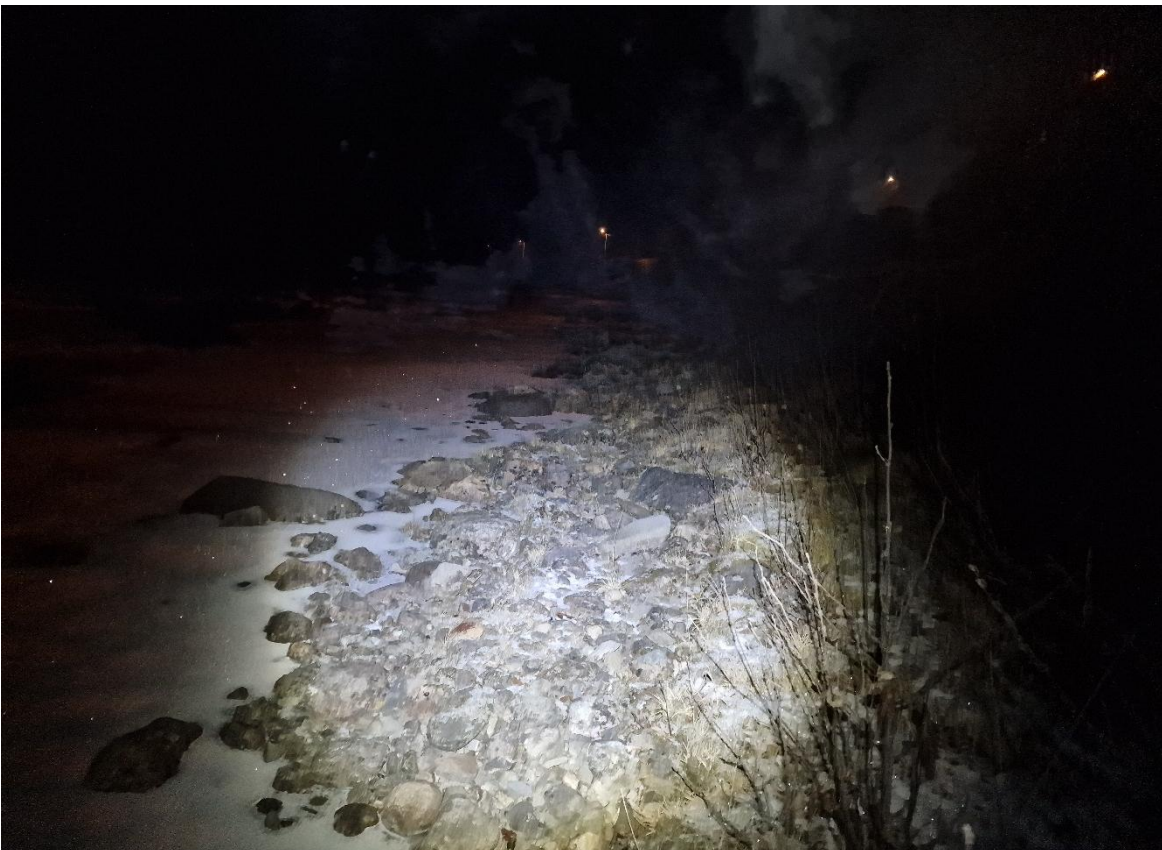
Figur 4-9 Bilde 170636, naturlig erosjonssikring langs Beiarelva.
