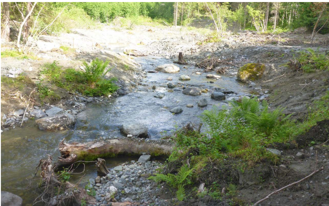
Bilde 7: Fra midtre del av Hofstadelva etter sikringsarbeidet er gjennomført
