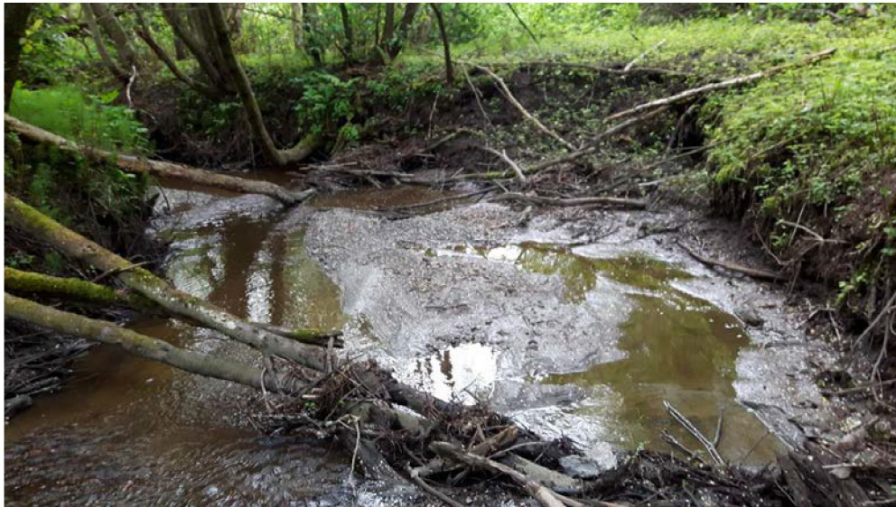
Bilde 9: Tydelig erosjon og graving inn mot siden.
