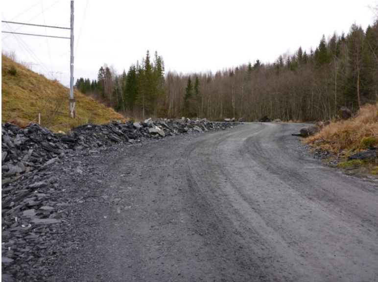
Bilde 5: Hofstadelva etter utkjøring av steinmasser. Midlertidig løp ved siden av anleggsveien. Bildet er fra desember 2014
