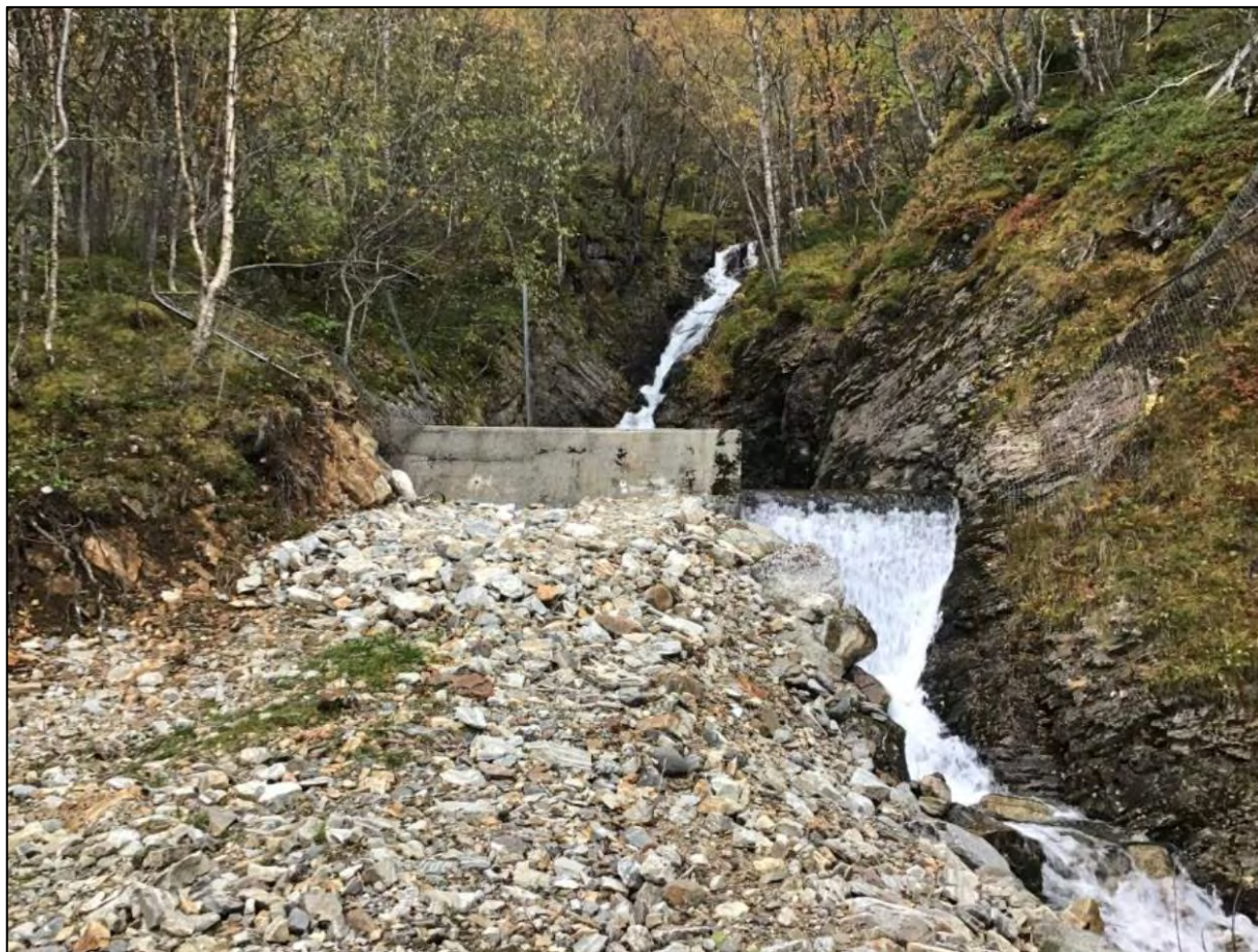
Figur 2-12. Inntaksdammen. Foto: Multiconsult.
