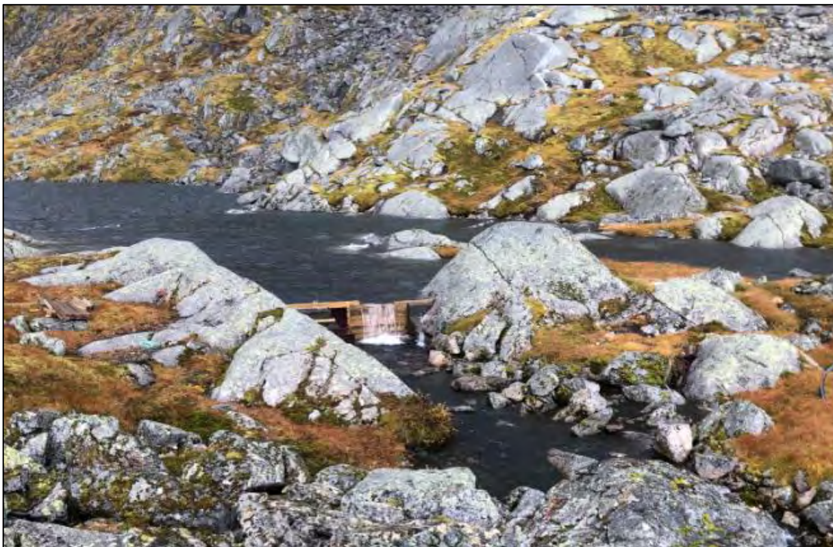
Figur 2-10. Dam Liåvatnet. Foto: Vevelstad kommune.
