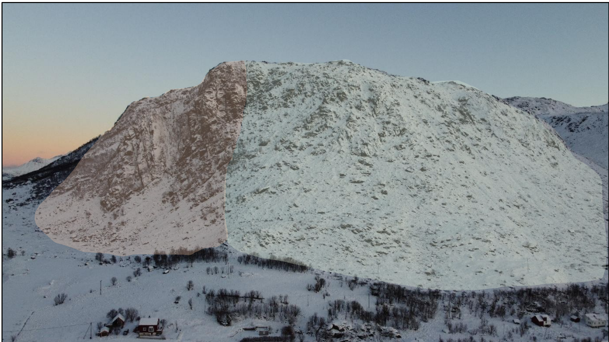
Figur 10: Løснеområder for steinsprang i den vestvendte delen av påvirkningsområdet (til høyre) har generelt lav egenhøyde og det er ikke sammenhengende ur i nedkant av skrentene. Løснеområder for steinsprang i den nordvendte delen av påvirkningsområdet (til venstre) har høyere egenhøyde og det er ur i nedkant av skrentene.
