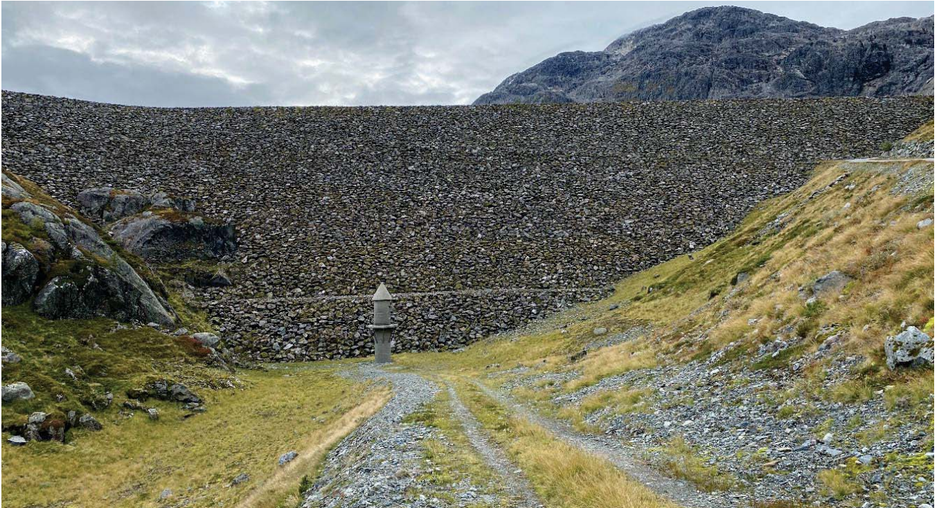
Figur 4-2: Det etableres et riggområde ved SKL sitt lekkasjemålehus.
