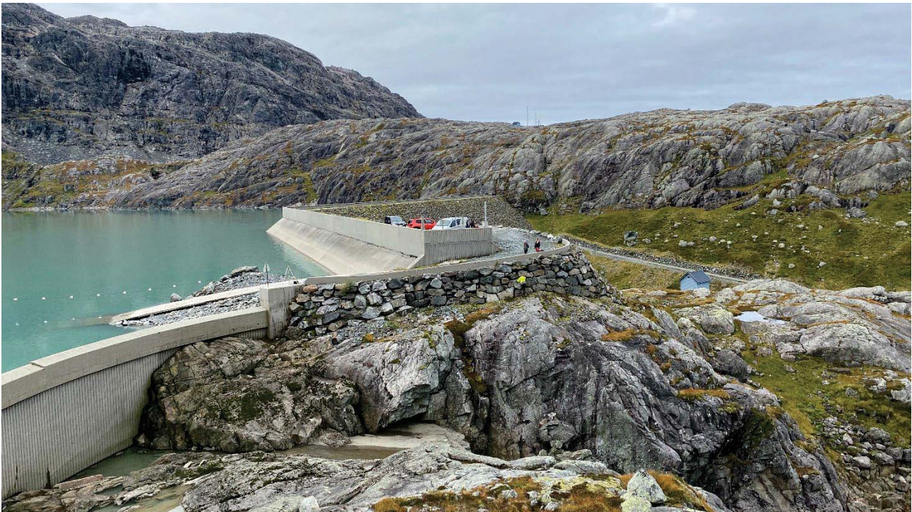
Figur 5-1: Tørrmuren som skal erstattes av støttemur i betong. Støttemuren kles med naturstein.
