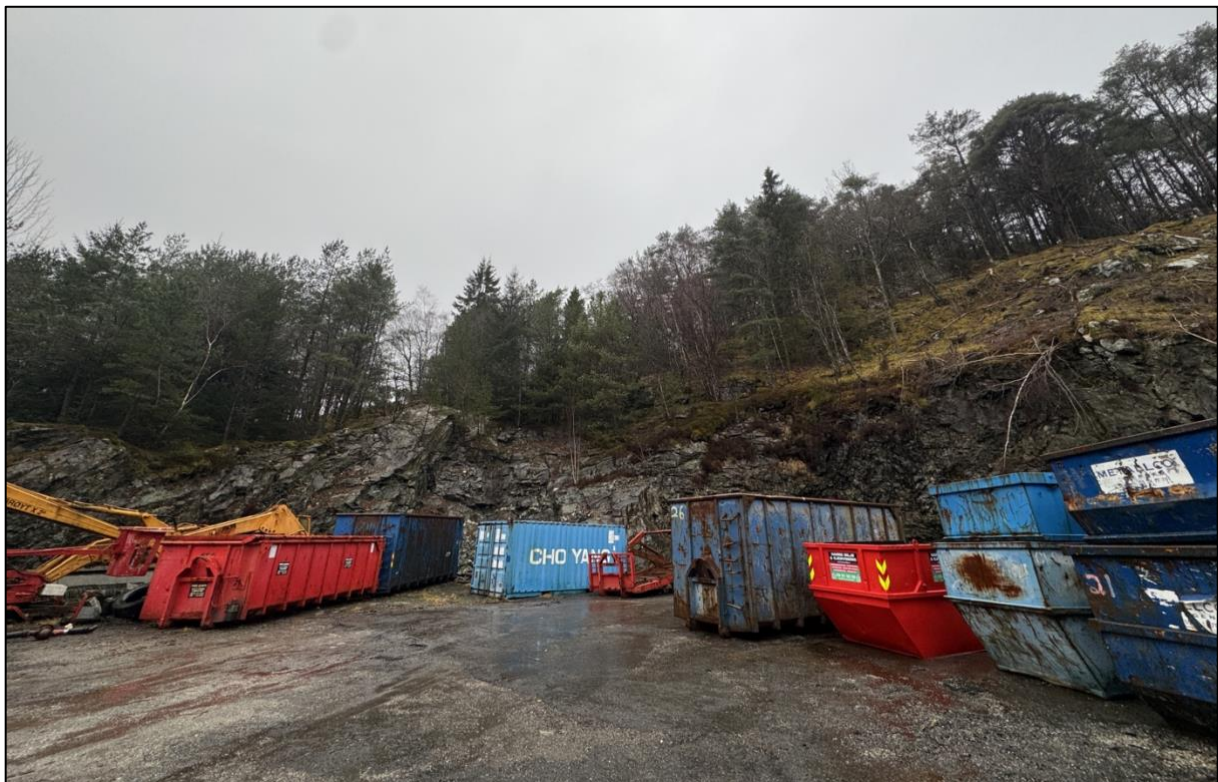
Figur 5: En utsprengt skjæring nord for kartleggingsområdet. Her fremstår berget noe mer oppsprukket enn i terrenget for øvrig. Stabiliteten i bergskjæringen er ikke vurdert i detalj.
