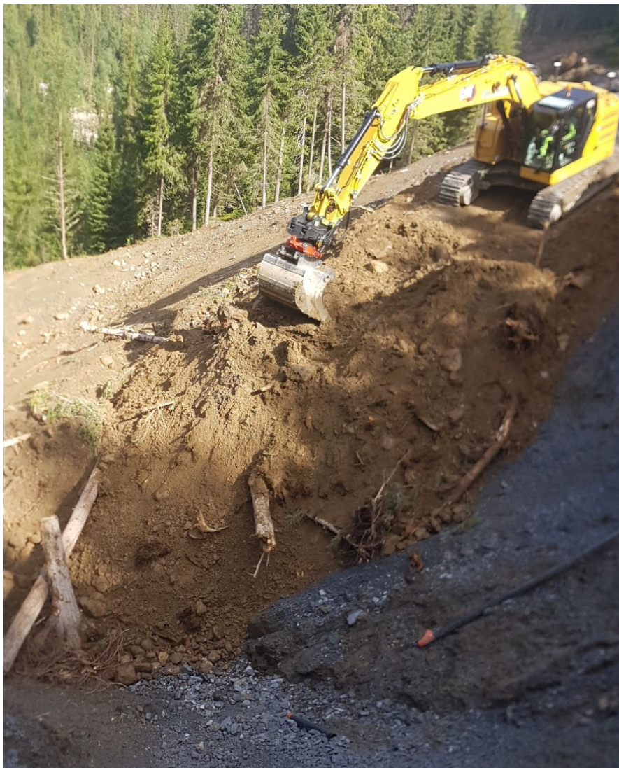
Bilde 4 Massar brukt til gjenoppbygging i 2023 ved pel 3030
