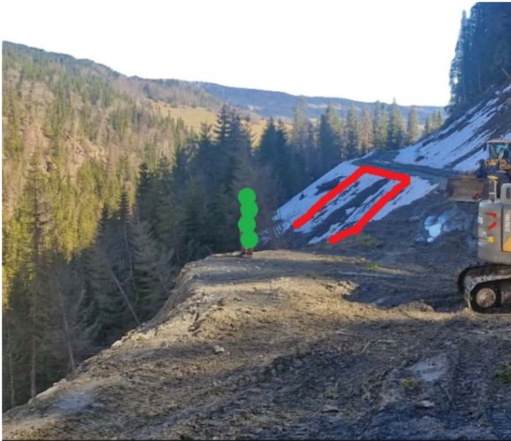
Bilde 2 Område for påbygging av vegskråning ved ca pel 2750
