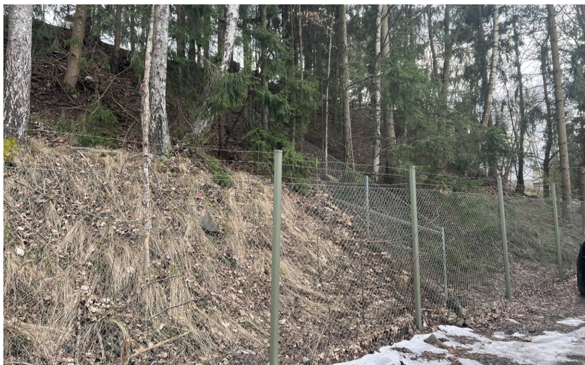
Figur 7: Bilde av skråningen ned mot Alnaelven i underkant av Tittutveien 12B. Bilde A.
