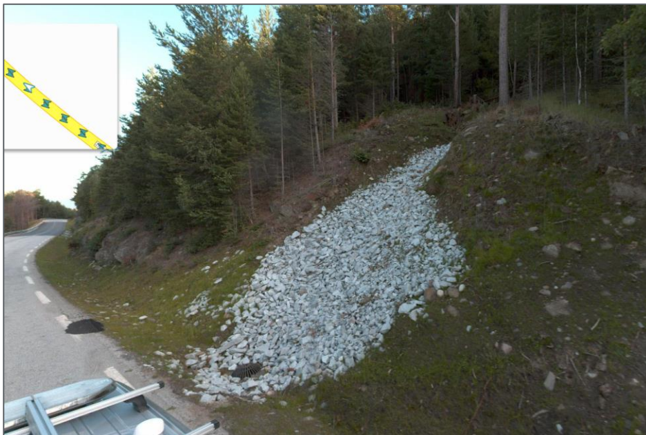
Figur 11 Skredhendelse nr. 1 (21.08.2023), i etterkant av oppryddingsarbeid fra vegkart.no [13].
