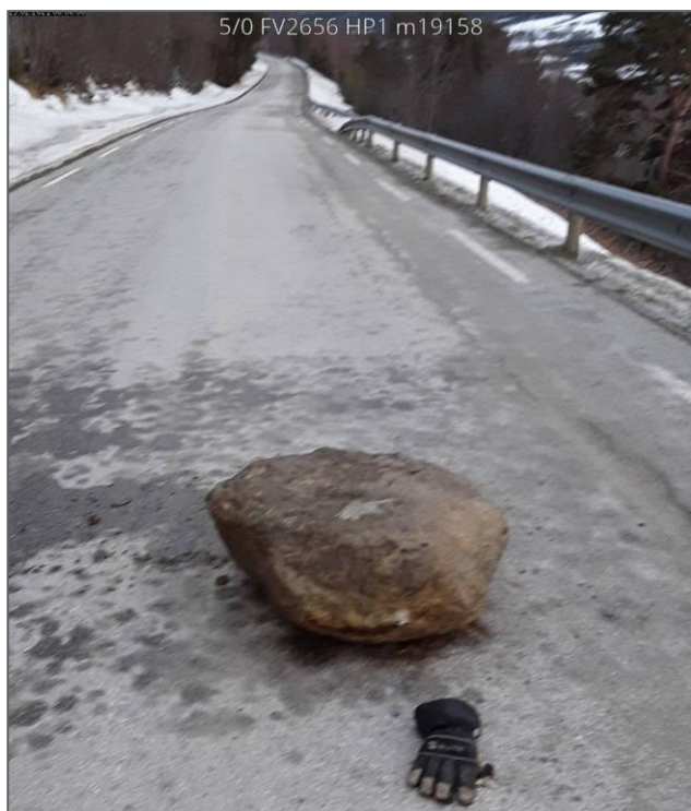
Figur 13 Skredhendelse nr. 7 (25.02.2021) [14], hvor en steinblokk traff vegen.
