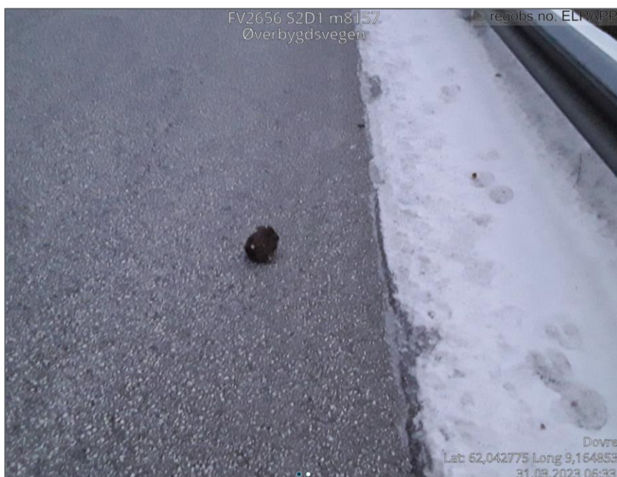
Figur 12 Skredhendelse nr. 6 (31.03.2023), hvor en liten steinblokk på størrelse med en tennisball traff vegen [14].
