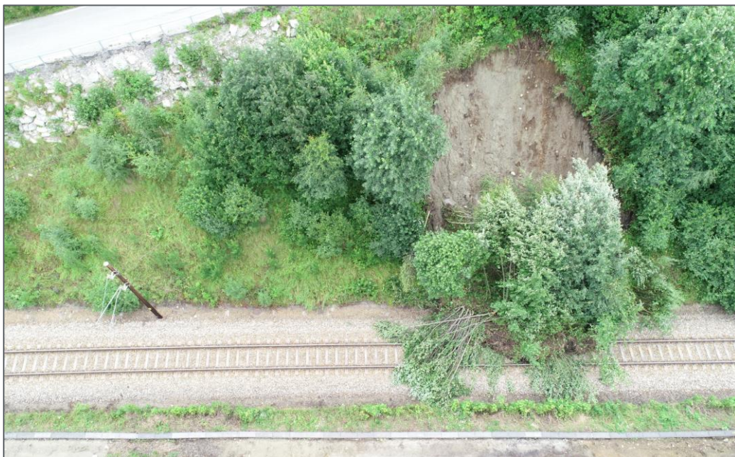
Figur 14 Skredhendelse nr. 8 (12.08.2023) [14], hvor et jordskred traff jernbanen.
