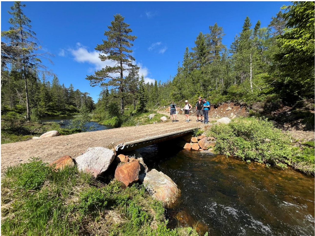
Figur 1-4. Bru over bekk.
