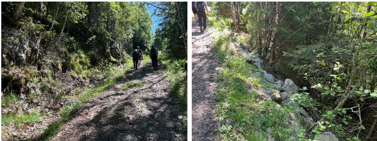
Figur 1-2. Stedvis svært bratte og smale partier på traktorveien. Bratt veifylling og fjell i dagen.
