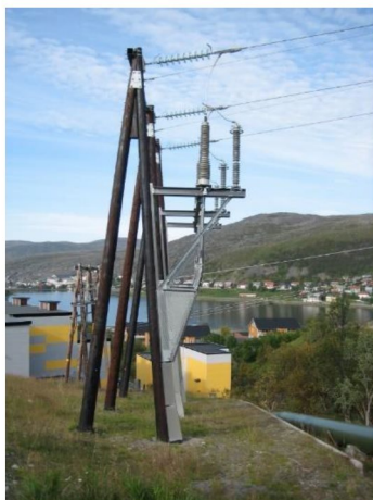
Figur 2-1. Prinsippskisse 132 kV trestolpemast (venstre). Normal mastehøyde 12-15 meter, men med enkelte mastepunkt rundt 20 meter. Faseavstand er normalt 5 meter hvilket gir en totalbredde på travers på ca. 10 meter og 5 meter mellom mastebein. Klausuleringsbeltet er ca. 10 meter ut fra ytterfase. (Midten) Eksempel på en kabelendemast som planlegges benyttet inn mot stasjonene. (Høyre) Prinsippskisse komposittmast med vertikaloppheng. Mastene blir normalt 20 meter høye med en vertikal faseavstand på ca. 3,5 meter.
