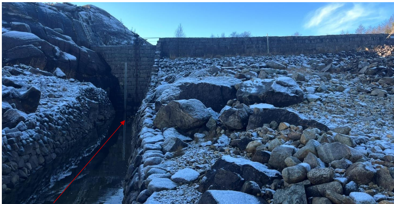
Figur 6 Tilsig ledes gjennom midlertidige rør som legges i kanalen
