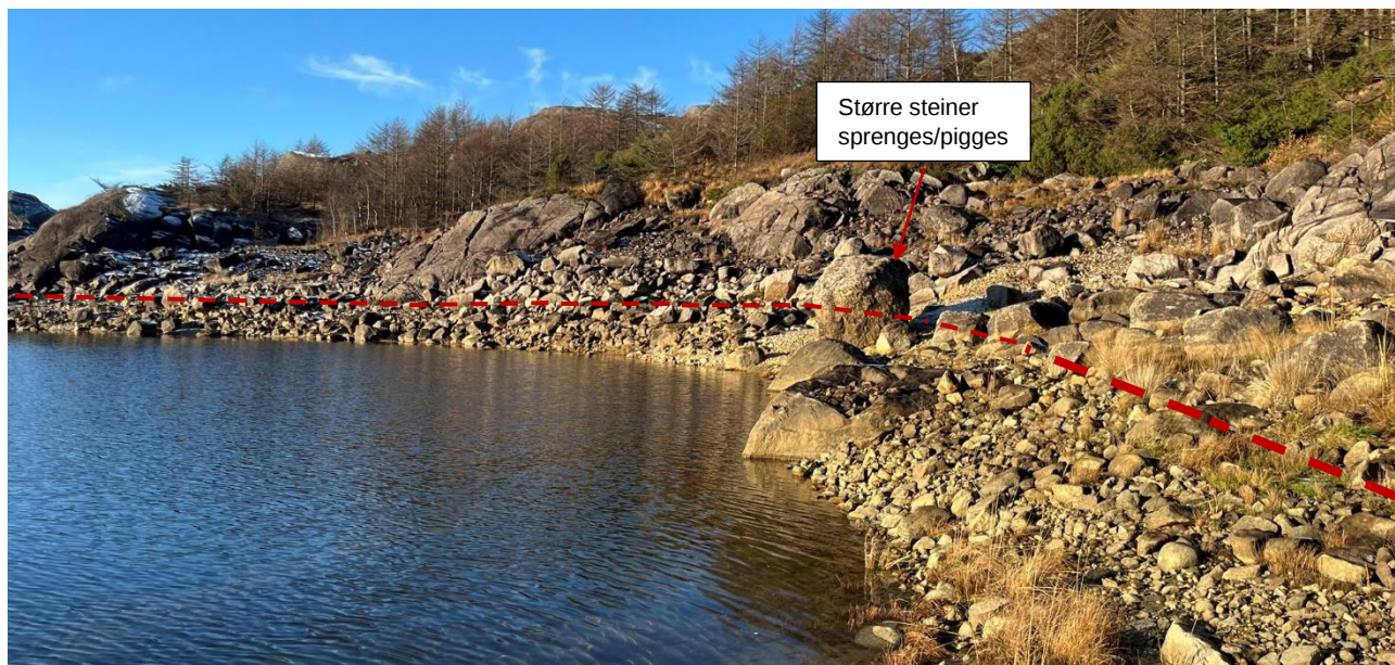
Figur 15 Rød stiplet linje viser omtrentlig trasé. Enkelte steder langs traseen muliggjør terrenget enkel opparbeidelse, mens det flere steder må fjernes større steiner og legges større mengder eksterne masser for å opparbeide veien.
