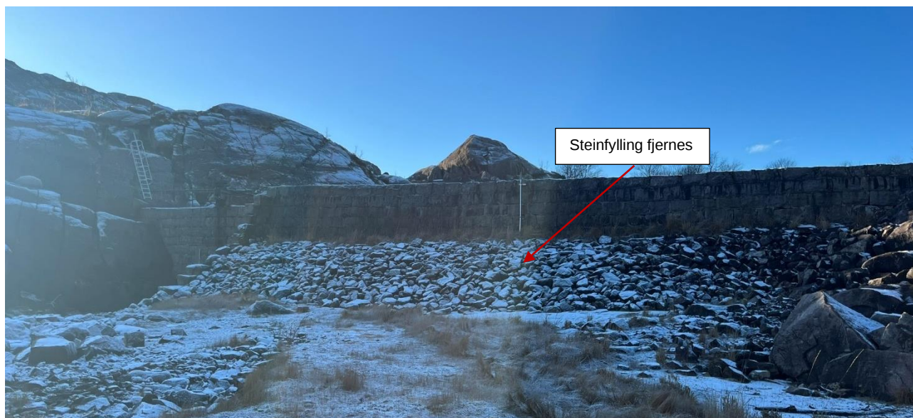
Figur 10 Steinfylling oppstrøms høyre damdel fjernes i sin helhet og benyttes til etablering av riggområde.
