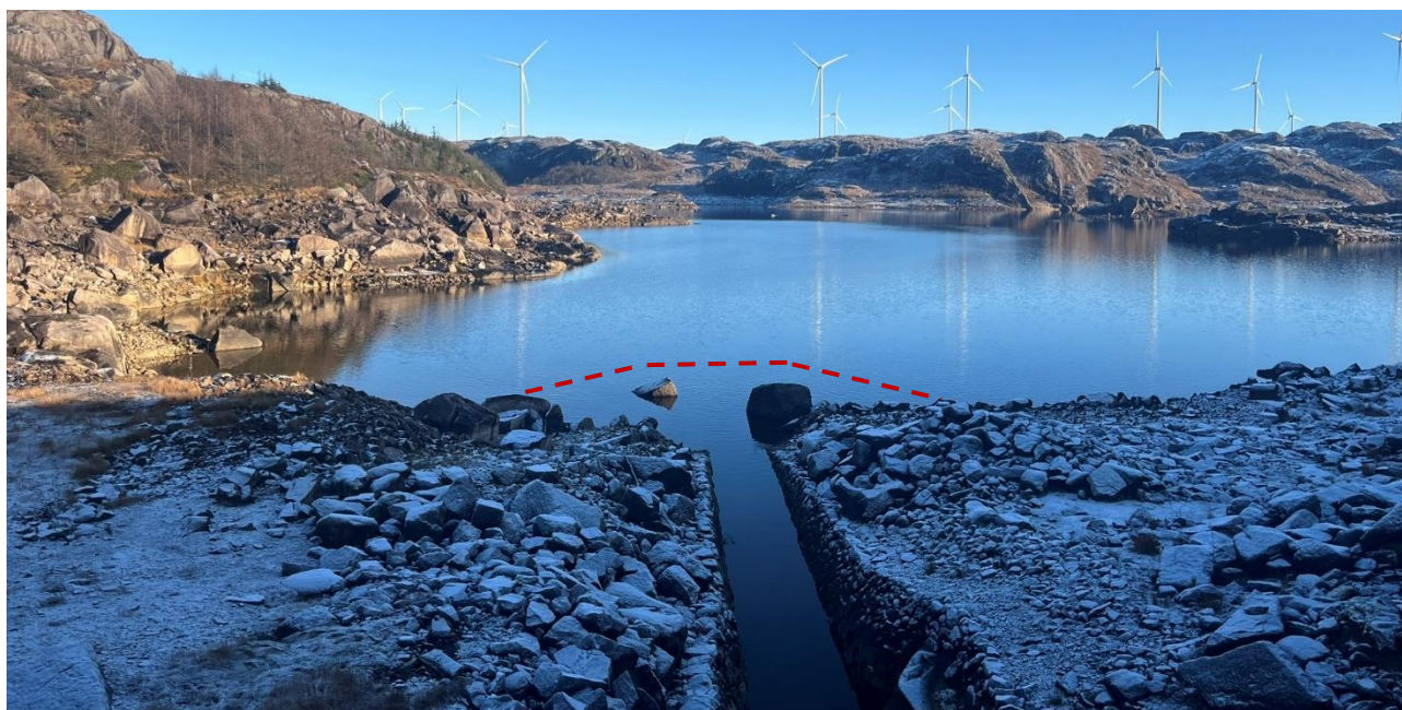
Figur 5 Rød stiplet linje viser omtrentlig plassering av midlertidig fangdam. Gravdal vindkraftverk ses i bakgrunnen.
