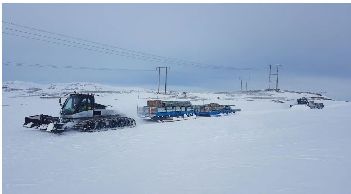
Figur 18: Bilde av tråkkemaskin og materialtransport om vinteren i forbindelse med bygging av 420 kV kraftledning
