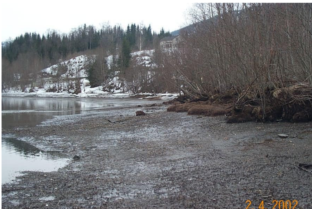
Bildet av den erosjonsutsatte parsellen ved Røssåga. Bildet er tatt ved fjære sjø.
