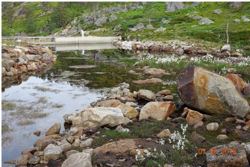
Figur 1 Dagens dam i utløpet av Ljosvatn
