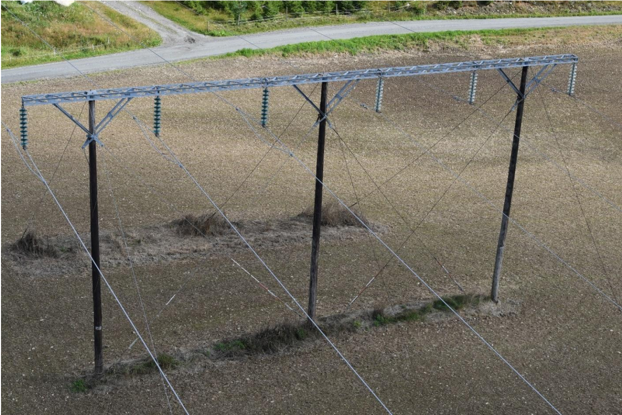
Figur 4-14. Typisk mastebilde for eksisterende 132 kV-ledninger som skal rives. Rydde- og byggeforbudsbeltet er ca. 42 m, 10 m ut fra ytterste fasen. Normal høyde 15-20 m.
