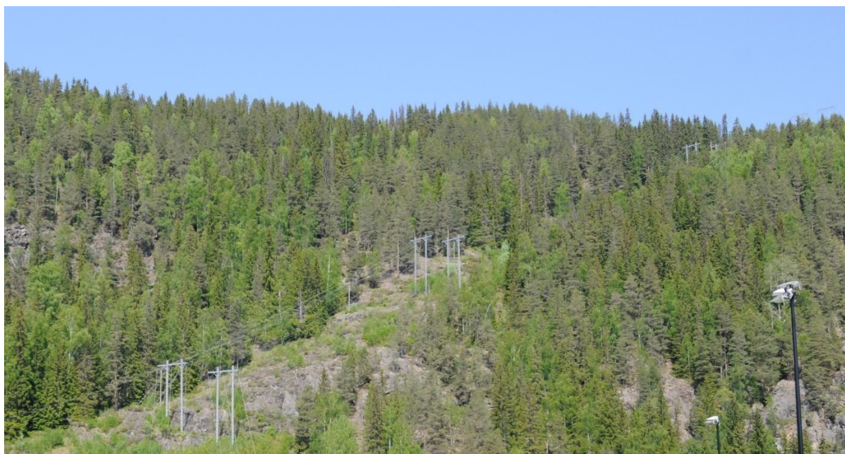
Figur 4-15. Bildet viser stålmastene ned mot Bagn transformatorstasjon.
