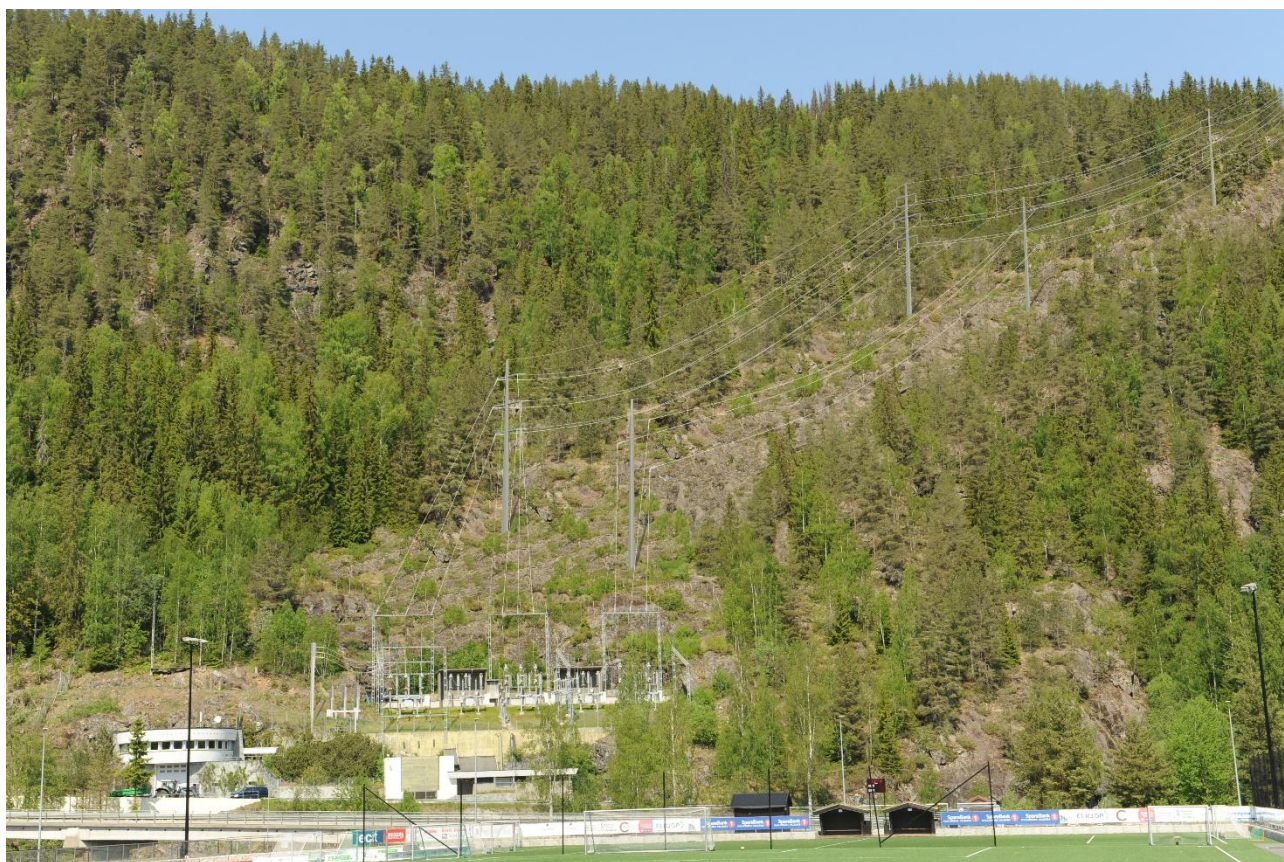
Figur 4-12 Bagn stasjon med planlagt nytt felt til venstre for eksisterende anlegg
