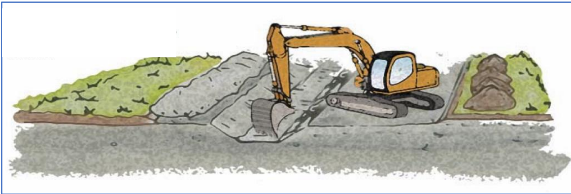
Figur 10-14. Massene som graves ut med gravemaskin legges opp langsmed kabelgrøfta.
