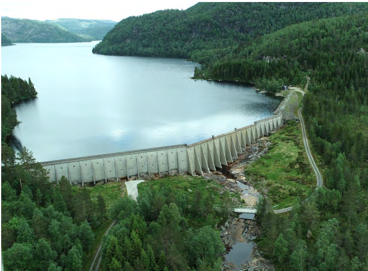
Figur 1-3 Oversikt over dam Nespervatn.
