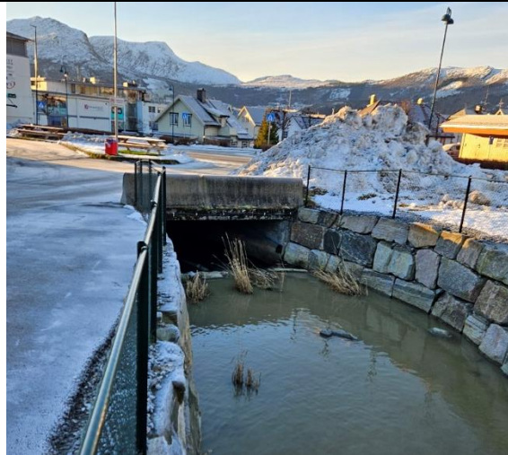
GT02 sett fra oppstrøms side
