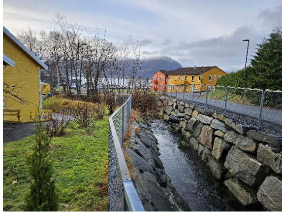
Vollen i OS03 er vist i bakgrunnen på bildet. Oppstrøms er elveløpet muret opp.
