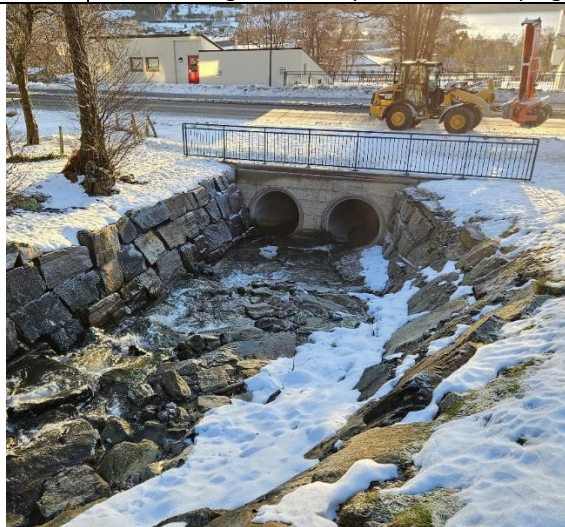
GK05 sett fra oppstrøms side.
