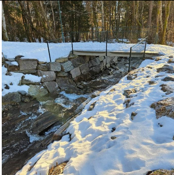
GK03 sett fra oppstrøms side.
