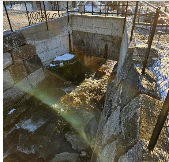
GK06 sett fra oppstrøms side.
