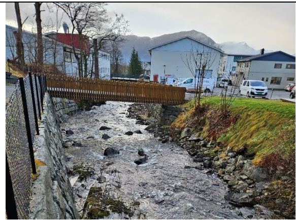
ØB05 sett fra oppstrøms side.
