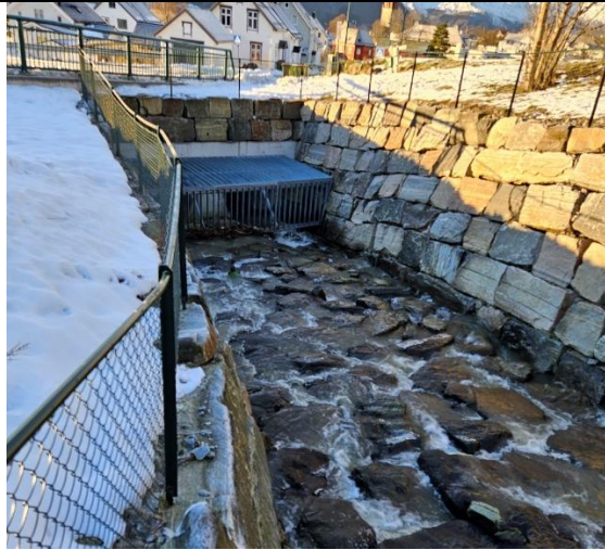
GK08 sett fra oppstrøms side.
