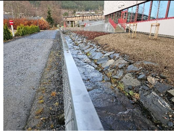
Omlagt elveløp oppstrøms OK15.
