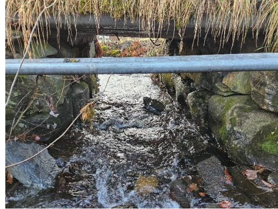
Innløpet til OK11.
