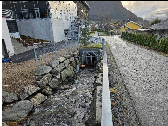
Innløpet til OK15.
