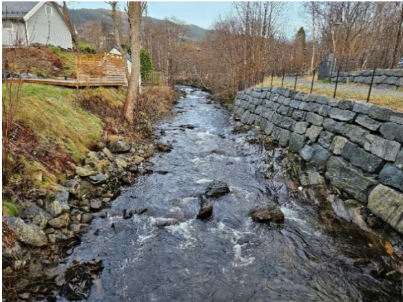
Figur 8: Elveløpet sett oppover fra gangbrua (ØB06) rett oppstrøms E39 Ristevegen.
