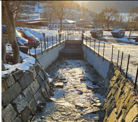
GT01 sett fra oppstrøms side.
