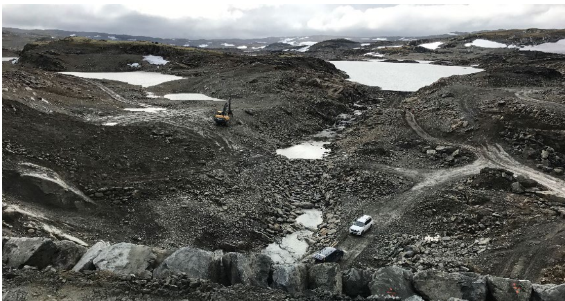
Figur 2 Bilete teken frå dam Kvevotni ved førre rehabilitering av dammen. Terskel i enden av vatnet er på høgde med LRV for Flågrunnsvatni.
