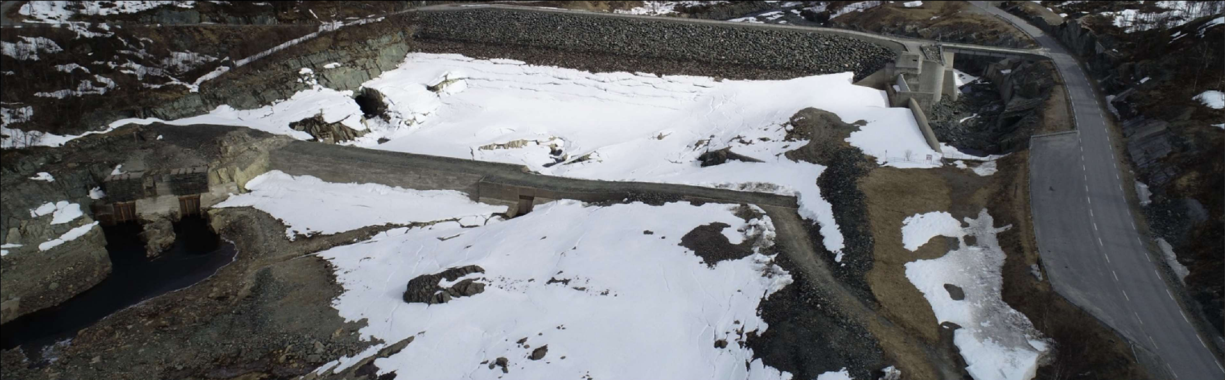
DRONEBILDE AV DAGENS SITUASJON. BILDET ER TATT 14. MAI 2020 VED VANNSTAND KOTE 900,55 moh.
